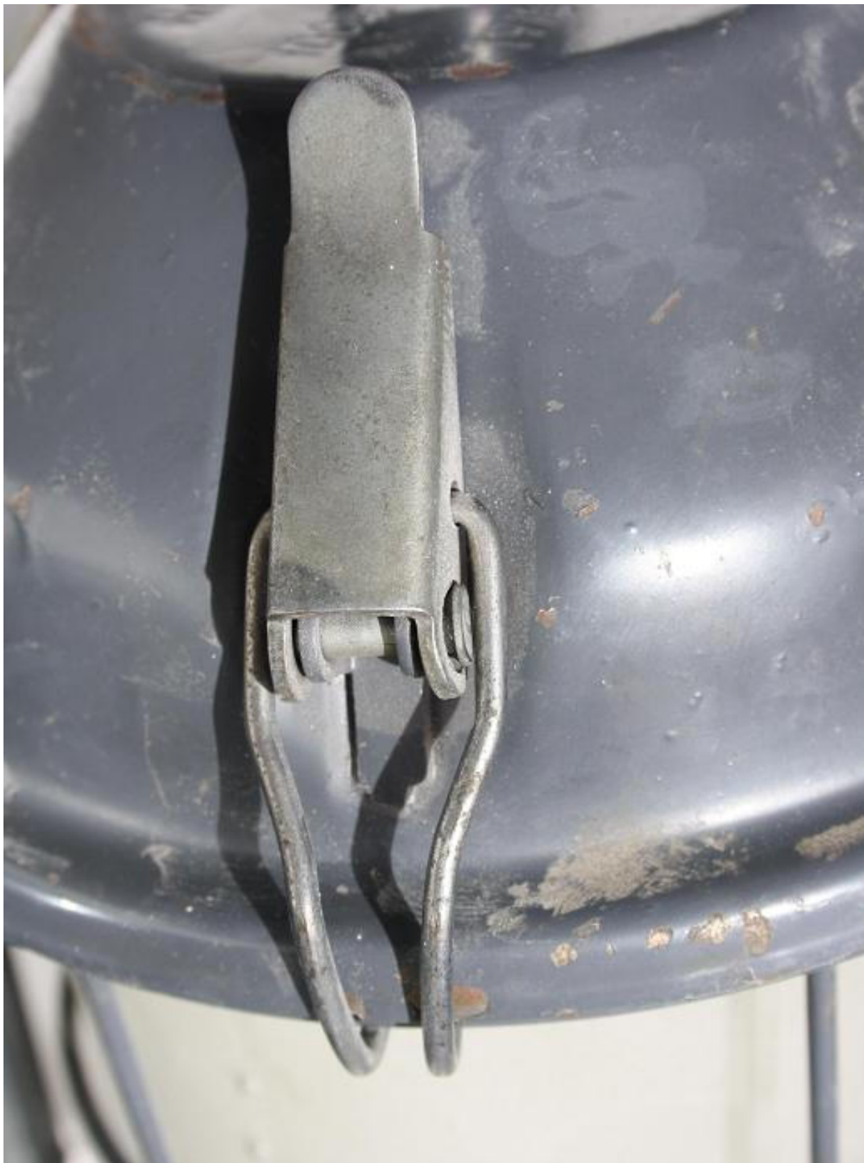
Рис. 7. Замок-застежка светильников НСП02 Версии 1 (1974-1978 годов). Крупный план в закрытом положении.
