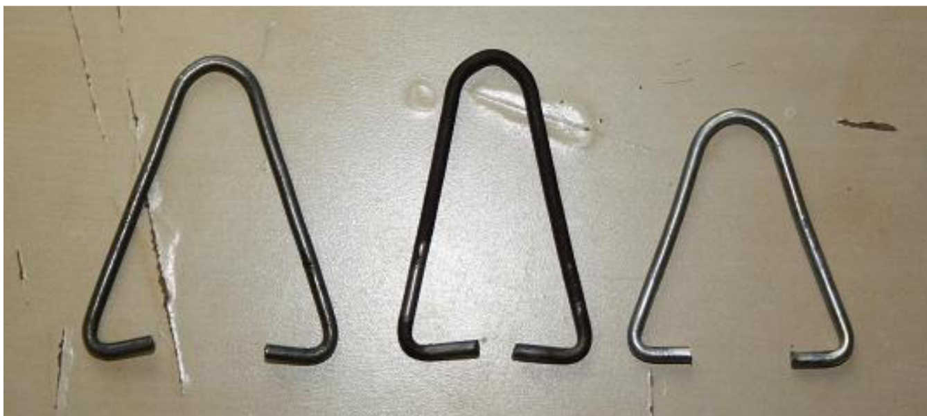
Рис. 24. «Вешалки» от светильников НСП02: слева 1974-1978 год, посередине 1979-1981, справа с 1982 года.
