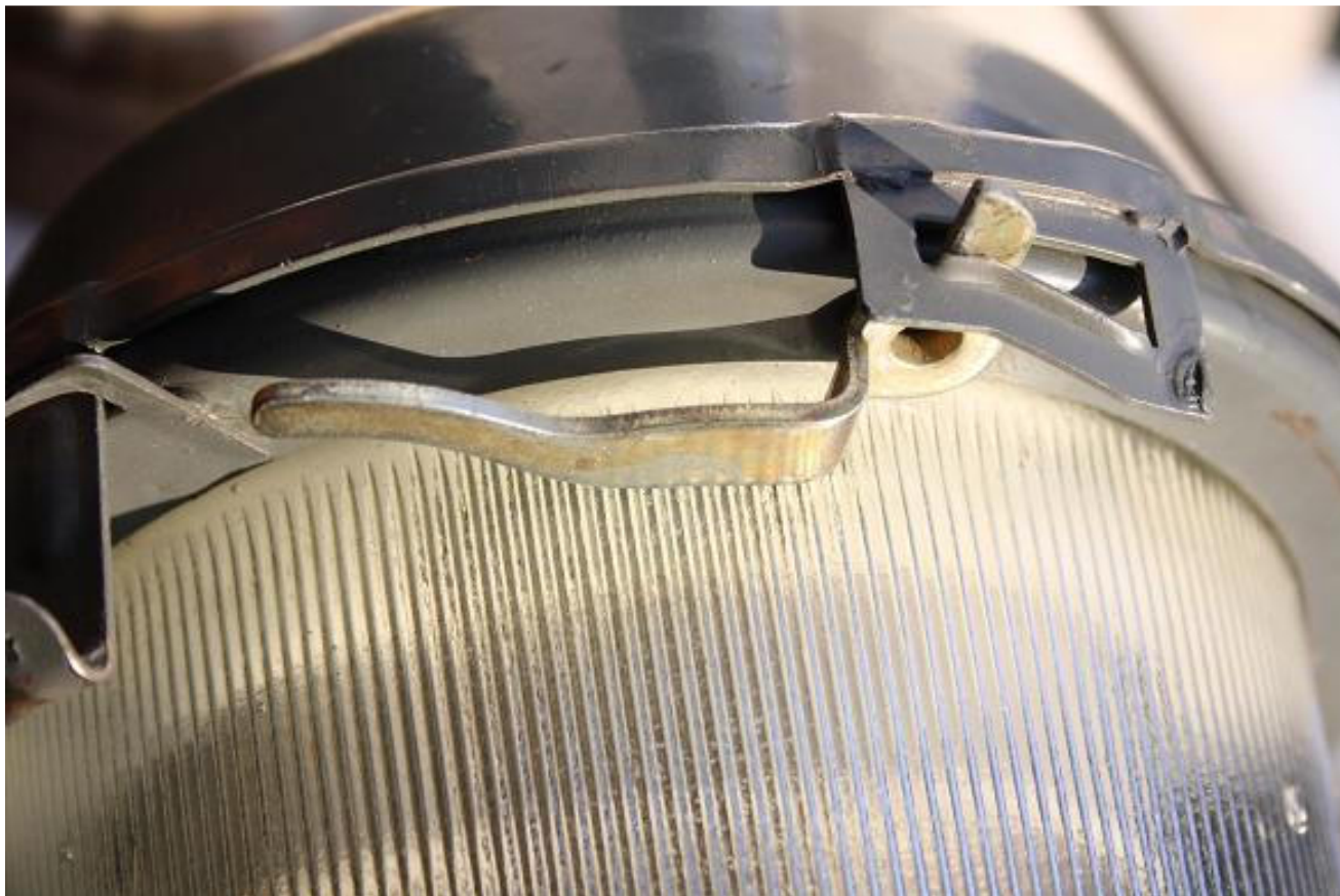
Рис 32. НСП02-100-001-У3 (12 1983) (МУПП ВОС). Замок-завдвижка и петли с треугольной прорезью.
