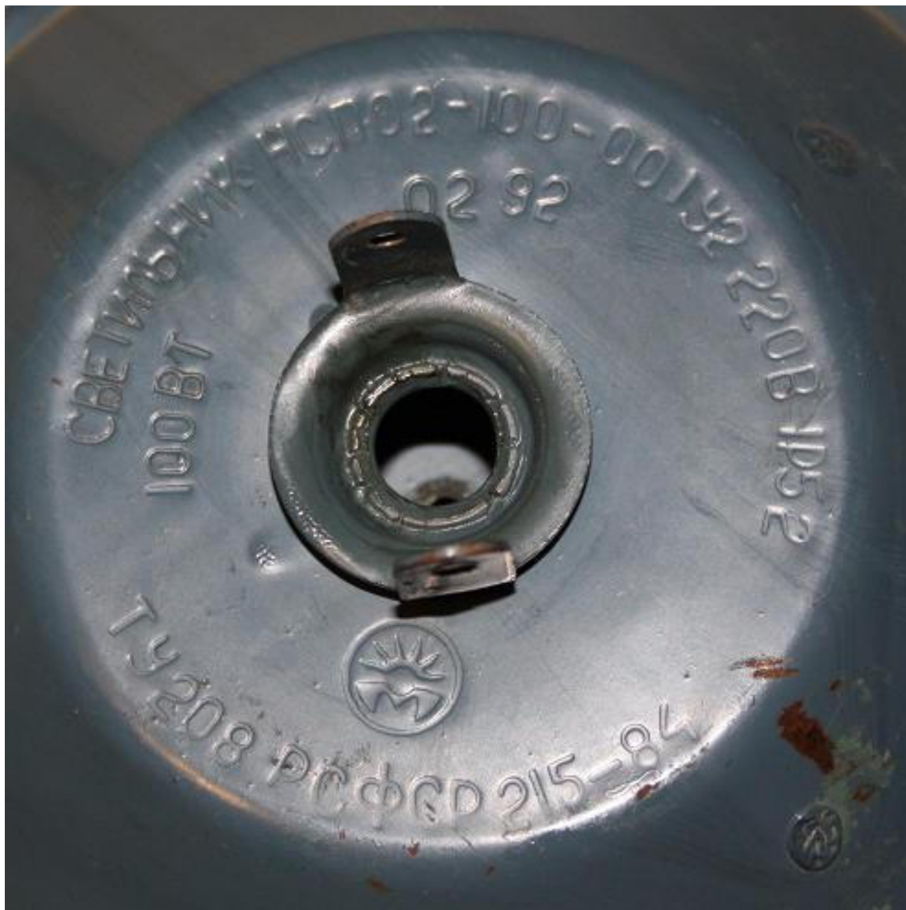
Рис. 43. Типовая маркировка светильника НСП02-100-001 У2 (МУПП ВОС)(1985-199х) на примере 02 1992.
