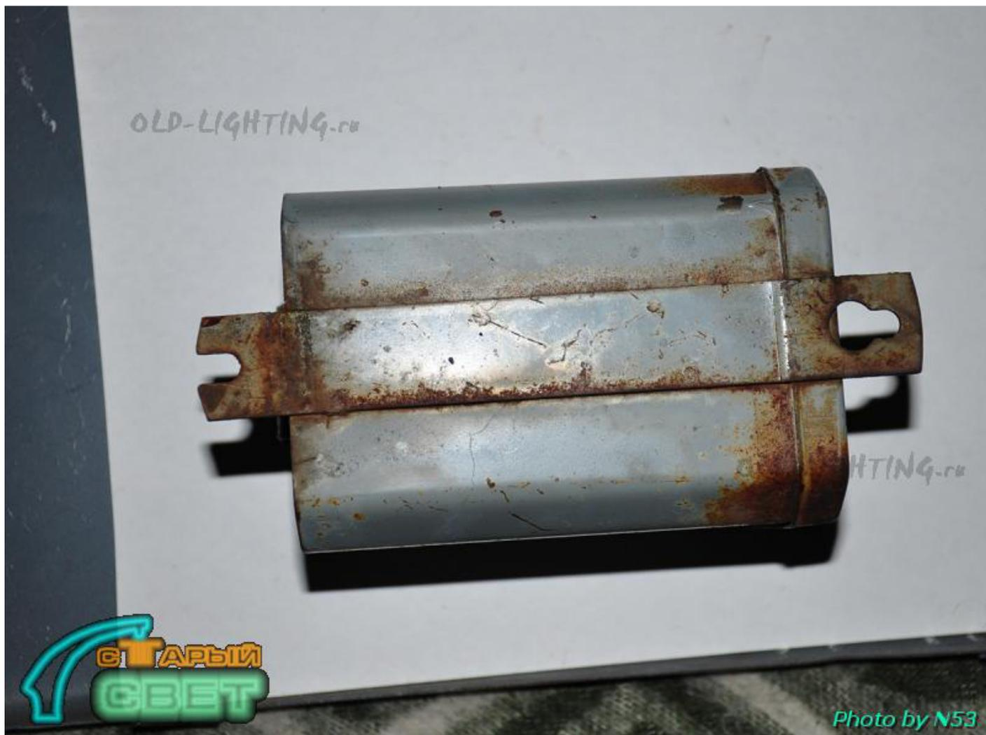
Рис. 39. Крепежная пластина на задней стороне румынского дросселя BVA-250.
