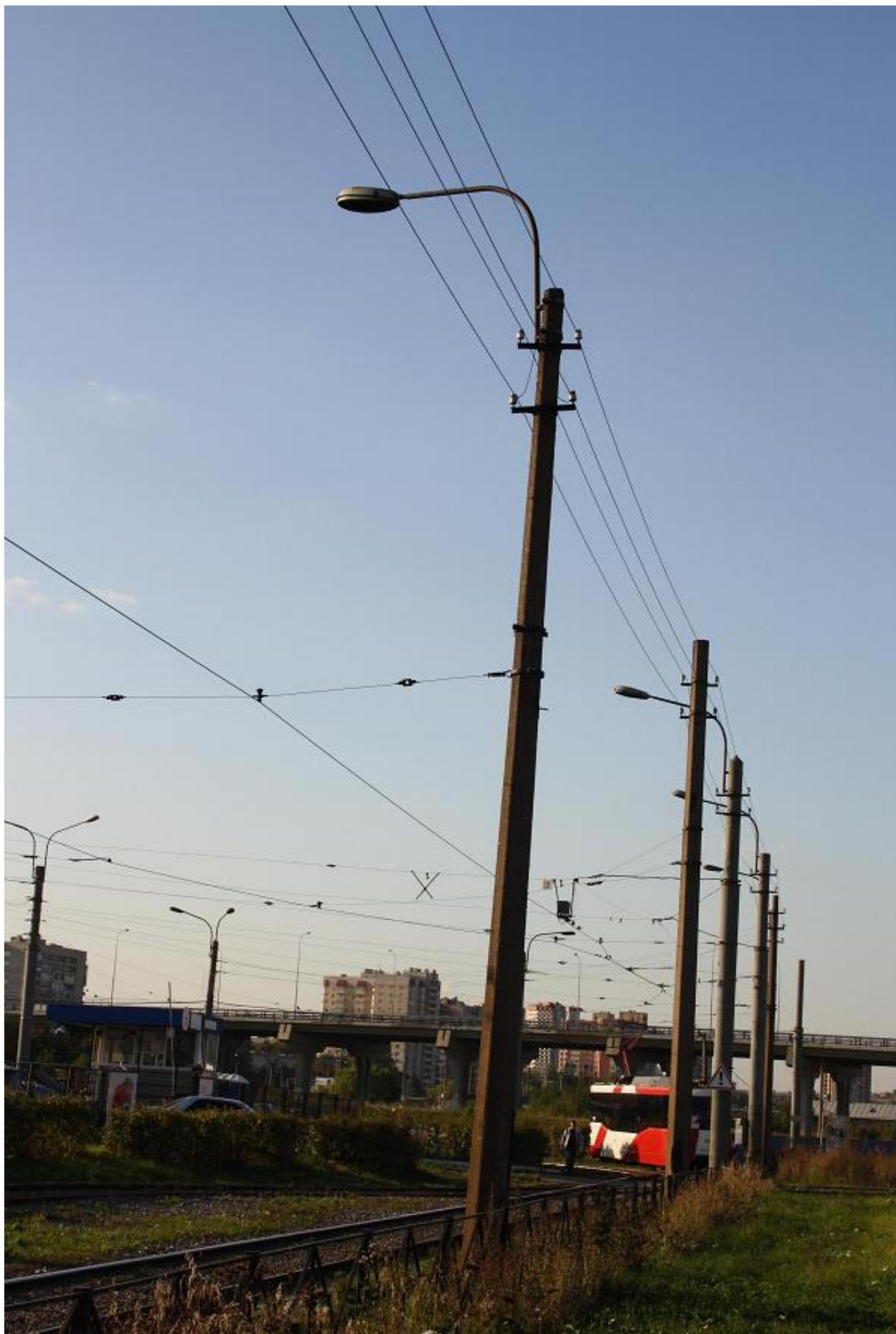
*Рис. 66. Линия освещения с новым типом консолей без скобок и светильниками РКУ01-400.*
