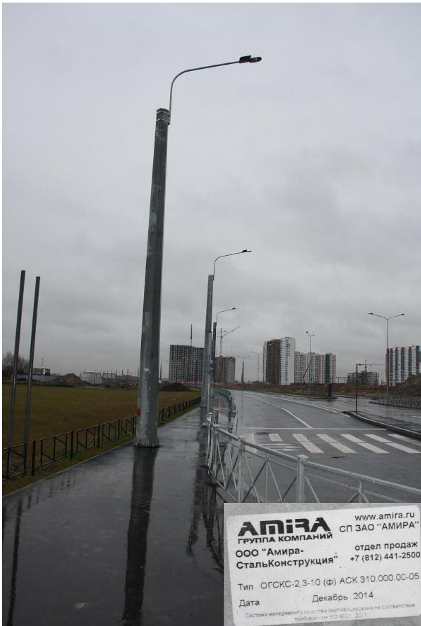
Рис. 133. Линия освещения со столбами ОГСКС-2,3-10 и боковыми консолями.
