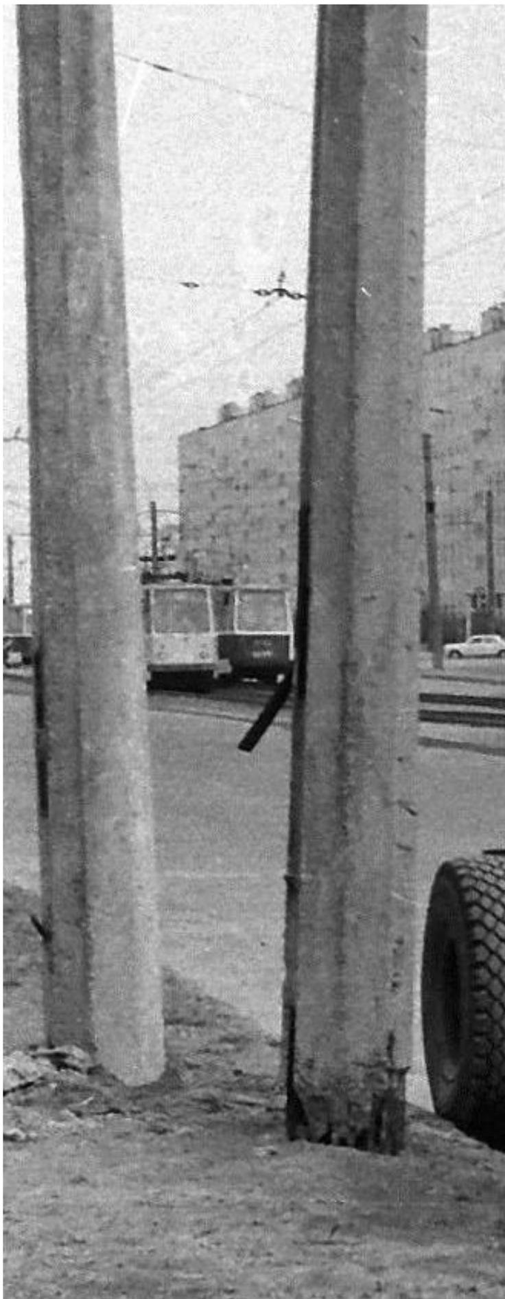
*Рис. 87. Замена сгнившего бетонного столба на новый старого образца. Улица Ярослава Гашека.*
