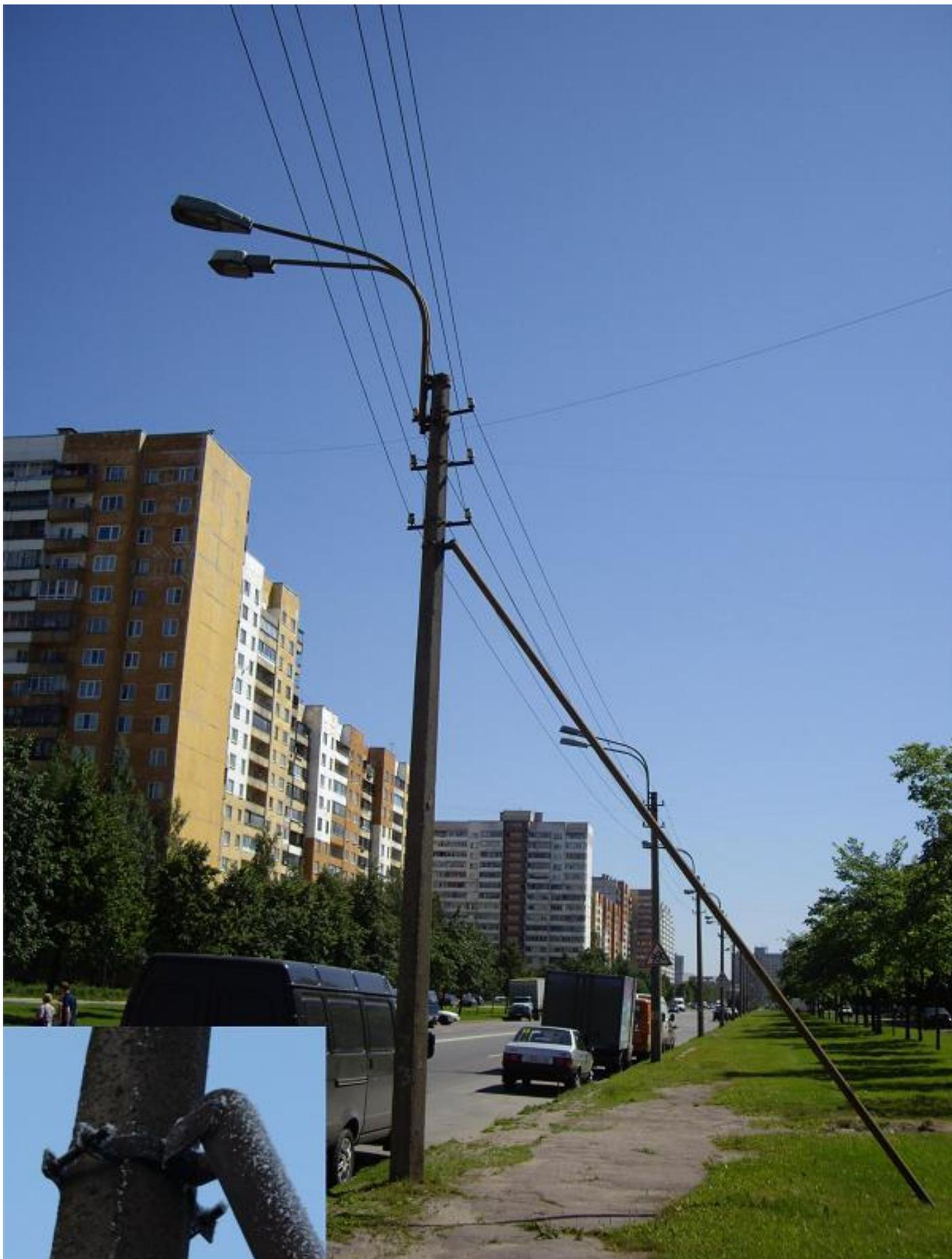
*Рис. 84. Столб с металлической подпоркой и узел фиксации крупным планом.*
