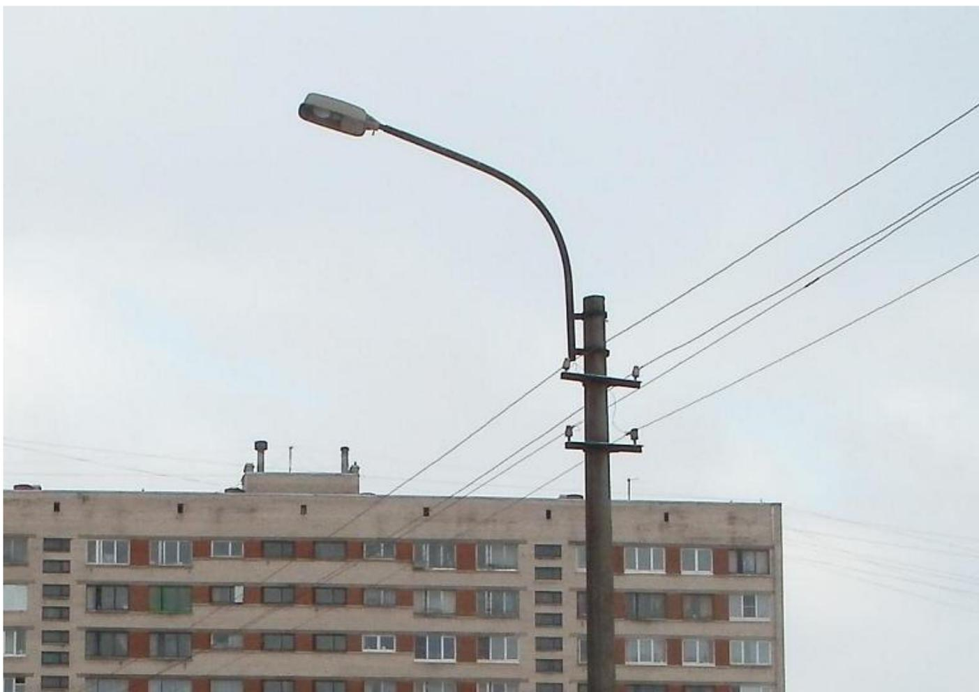
Рис. 92. Столб со светильником РКУ08 на линии освещения.
