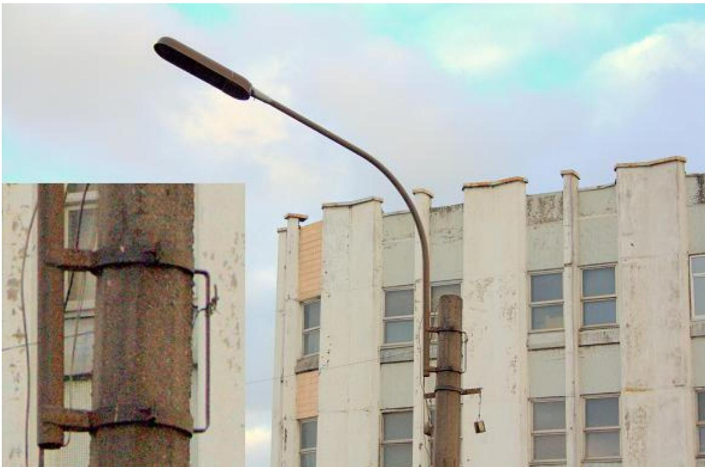
*Рис. 41. Консоль бокового крепления с крючком на скобке.*
