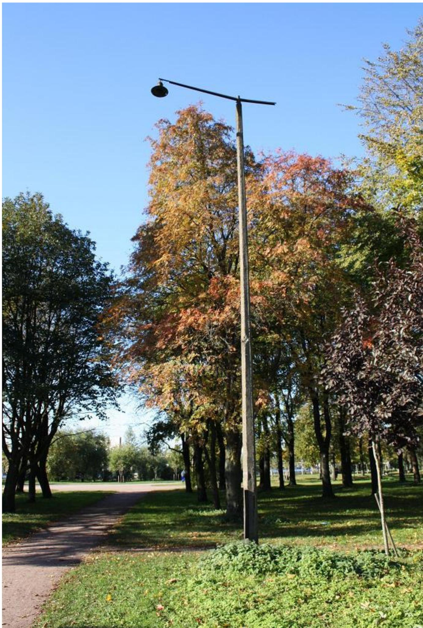
*Рис. 15. Столб с «прогнутой стрелой» и тонким стаканом.*
