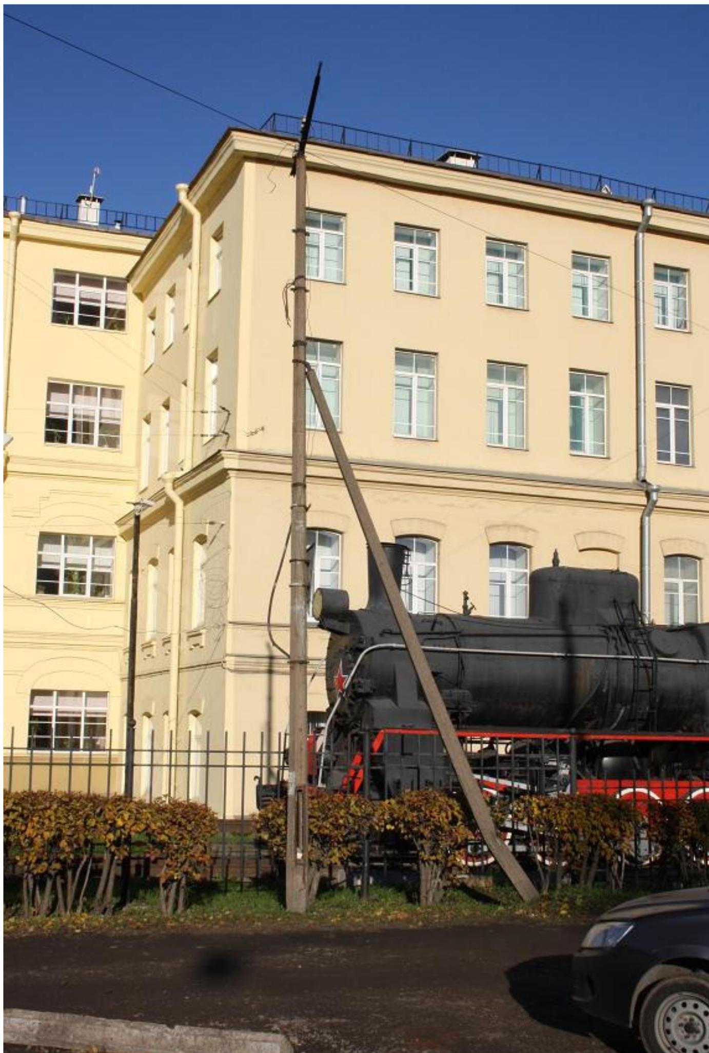
*Рис. 18. Столб с подпоркой и «прогнутой стрелой» с тонким стаканом.*
