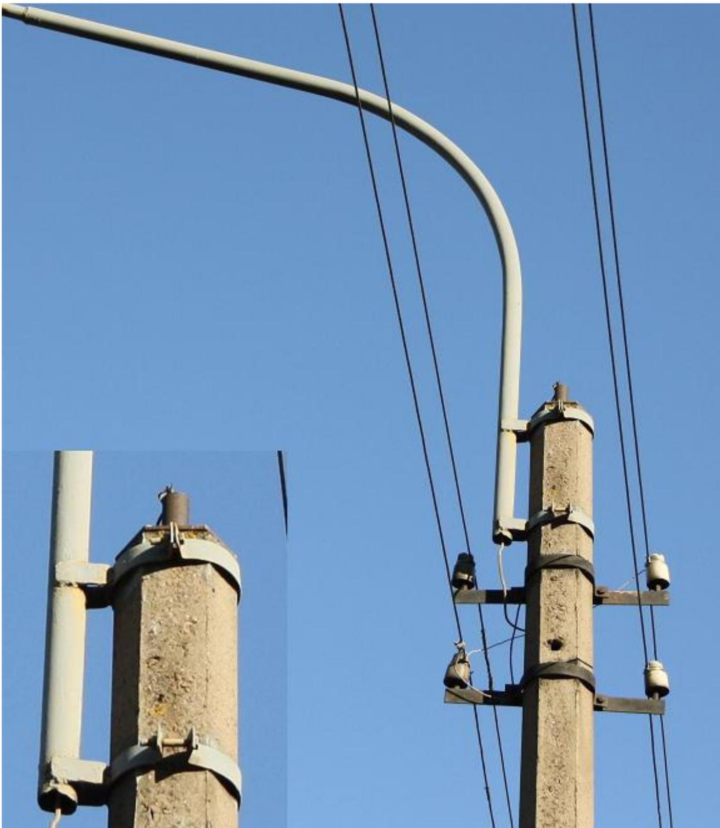
*Рис. 65. Боковая консоль без соединяющей скобки на столбе «СВ со штырьком».*
