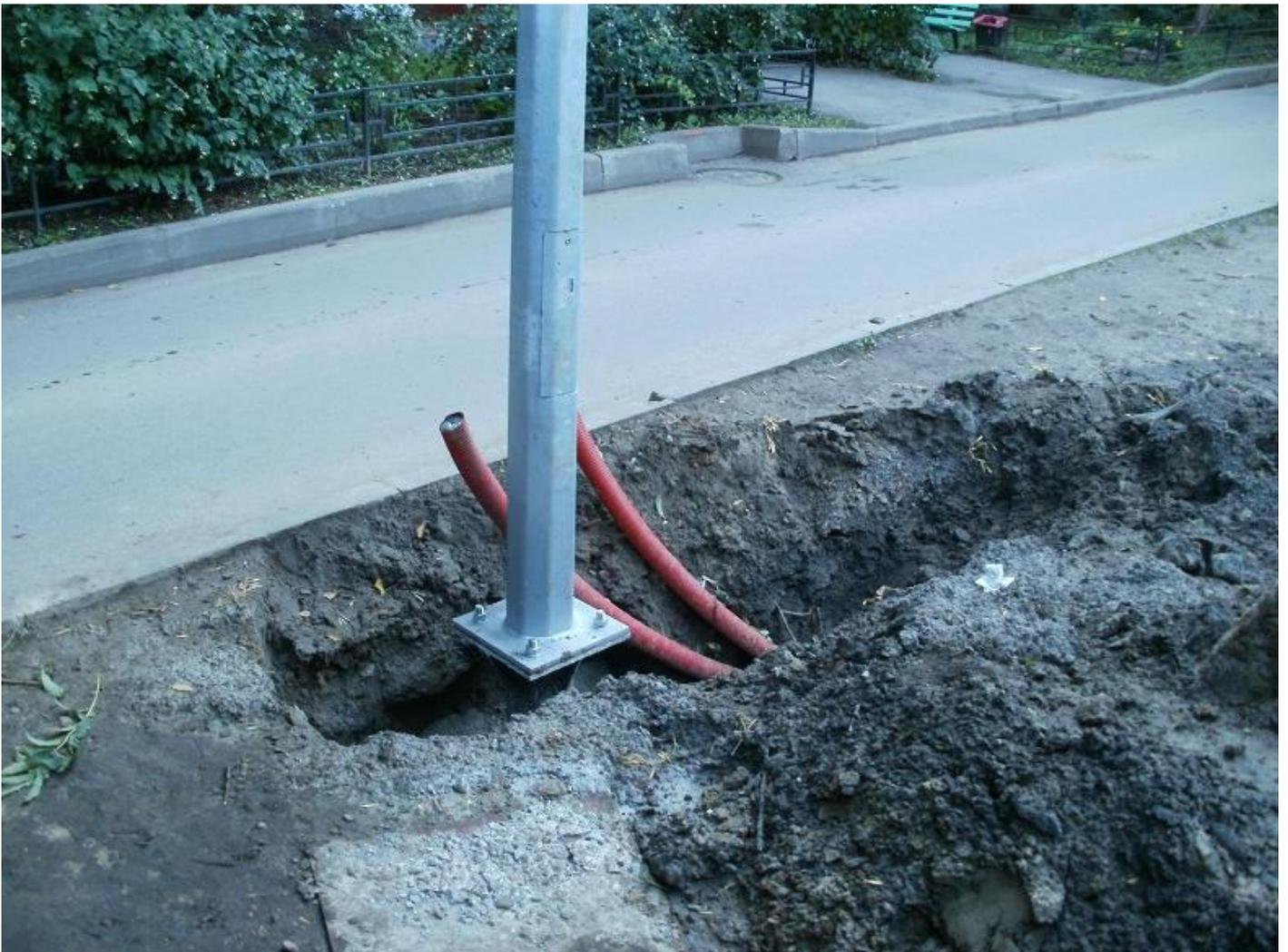
*Рис. 114. Установка галвеного оцинкованного столба. Подводка питающих кабелей.*
