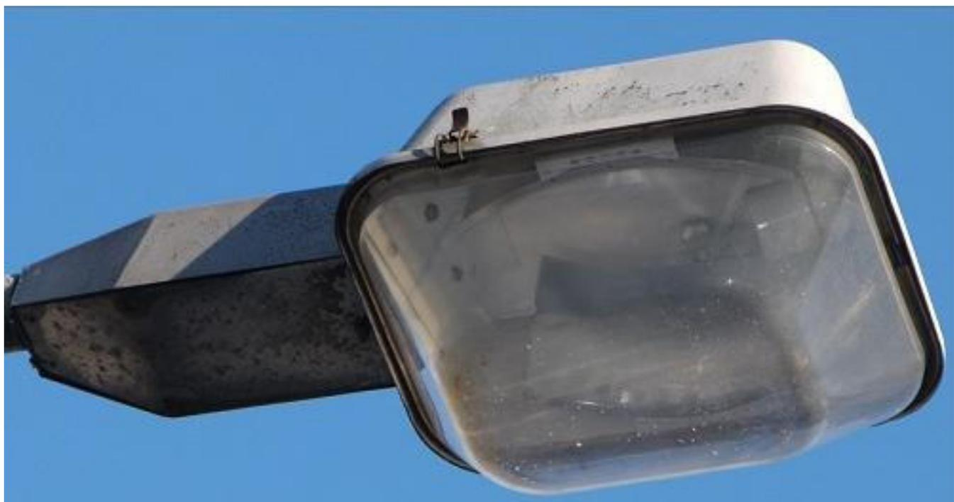
*Рис. 64. Светильник АДкп ранней версии крупным планом.*
