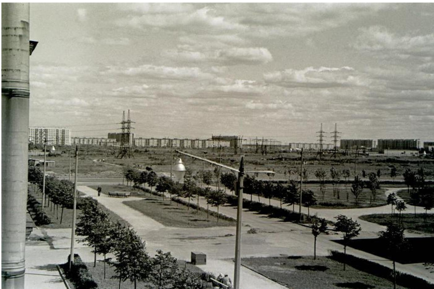
*Рис. 5. «Прогнутая стрела» с «шишкообразным» светильником и выносным ПРА. Алтайская улица. 1964 год.*
