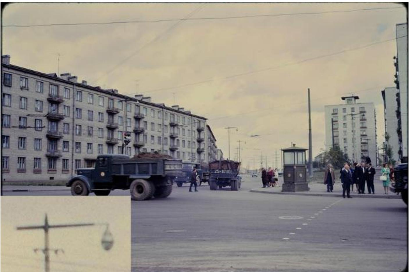
*Рис. 14. Стрела без штырей и уголок с такелажными изоляторами. Авто́вская улица 1964 год.*
