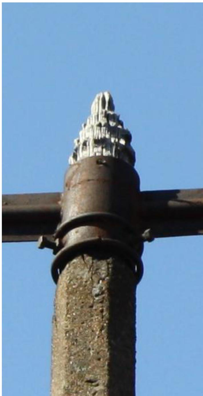
*Рис. 3. Стакан стрелы с зажимными болтами и деревянной шишечкой. Крупный план.*
