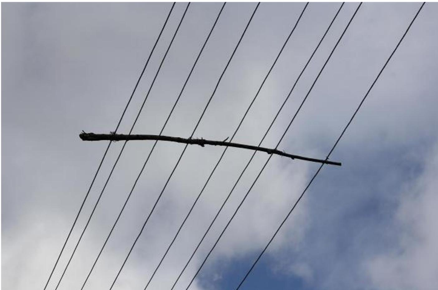
*Рис. 88. Борьба с короткими замыканиями. Тополиная палка в проводах.*
