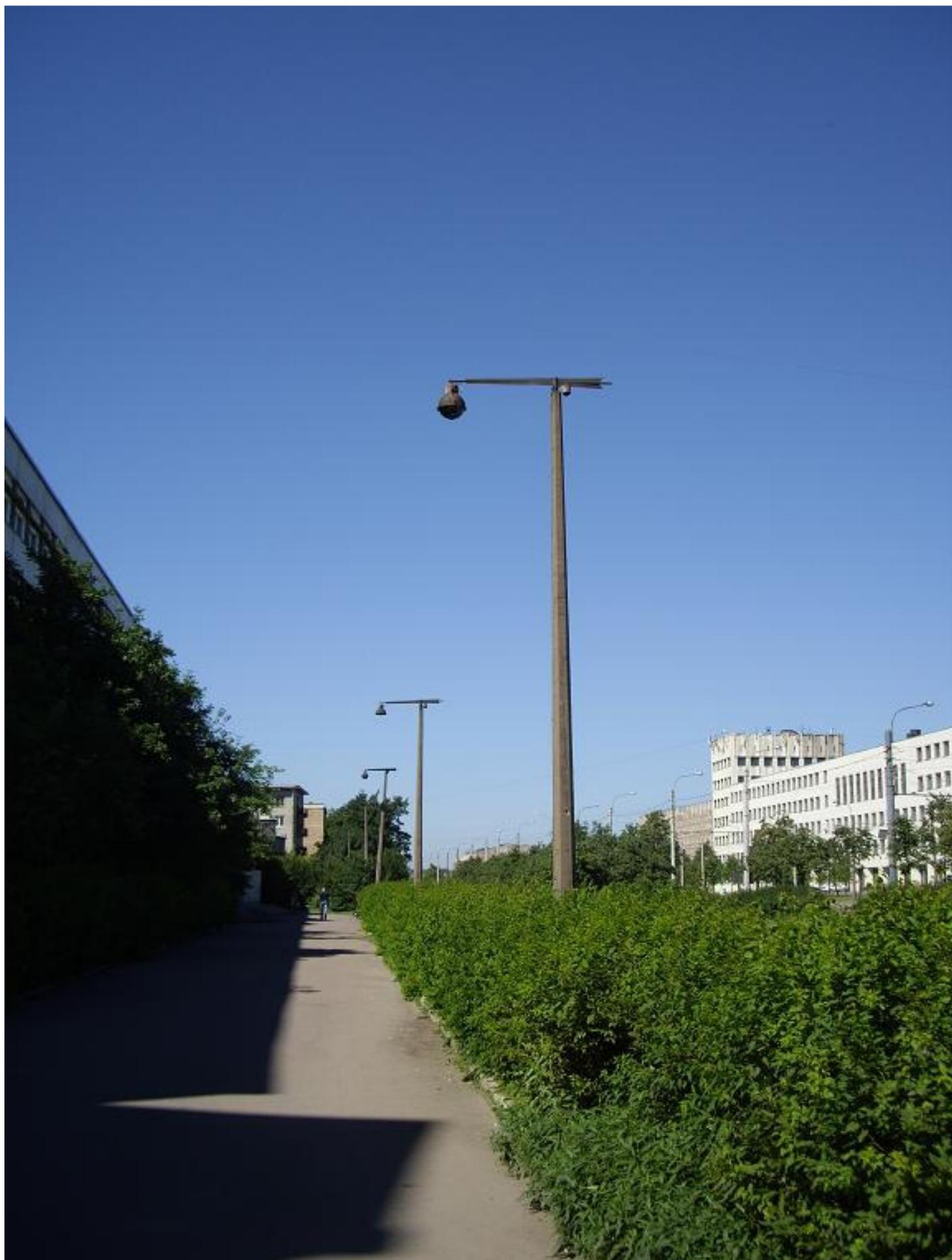
*Рис. 26. Линия освещения со стрелами и светильниками СПЗ-500. Дорожка вдоль АТиЭМТ Бухарестская улица.*
