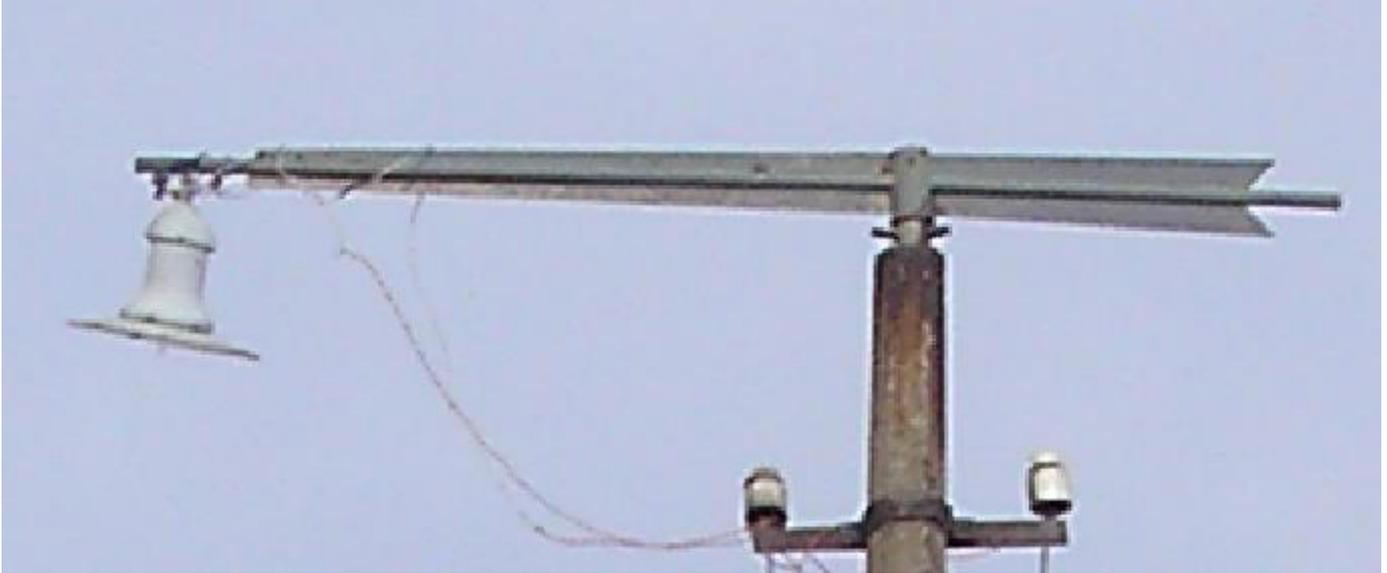
*Рис. 21. Окончательные варианты стрел с толстыми подкрылками и малым стаканом крупным планом.*
