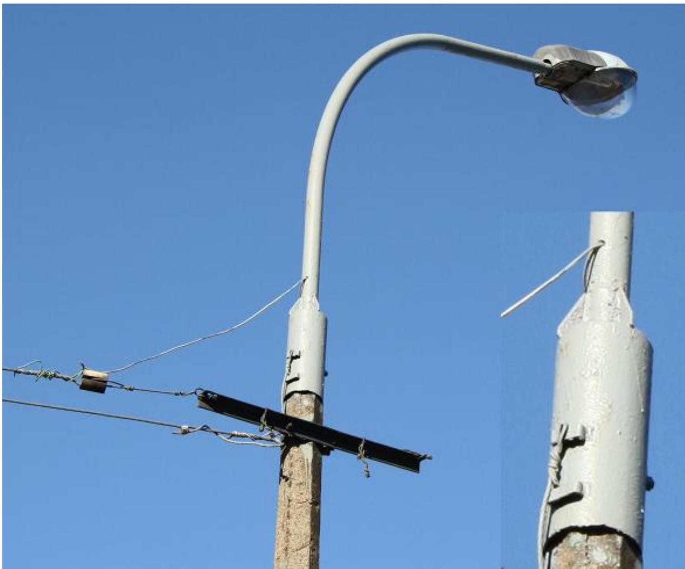
*Рис. 9. Консоль со стаканом без «коробки» и двумя петлями. Крупный план.*
