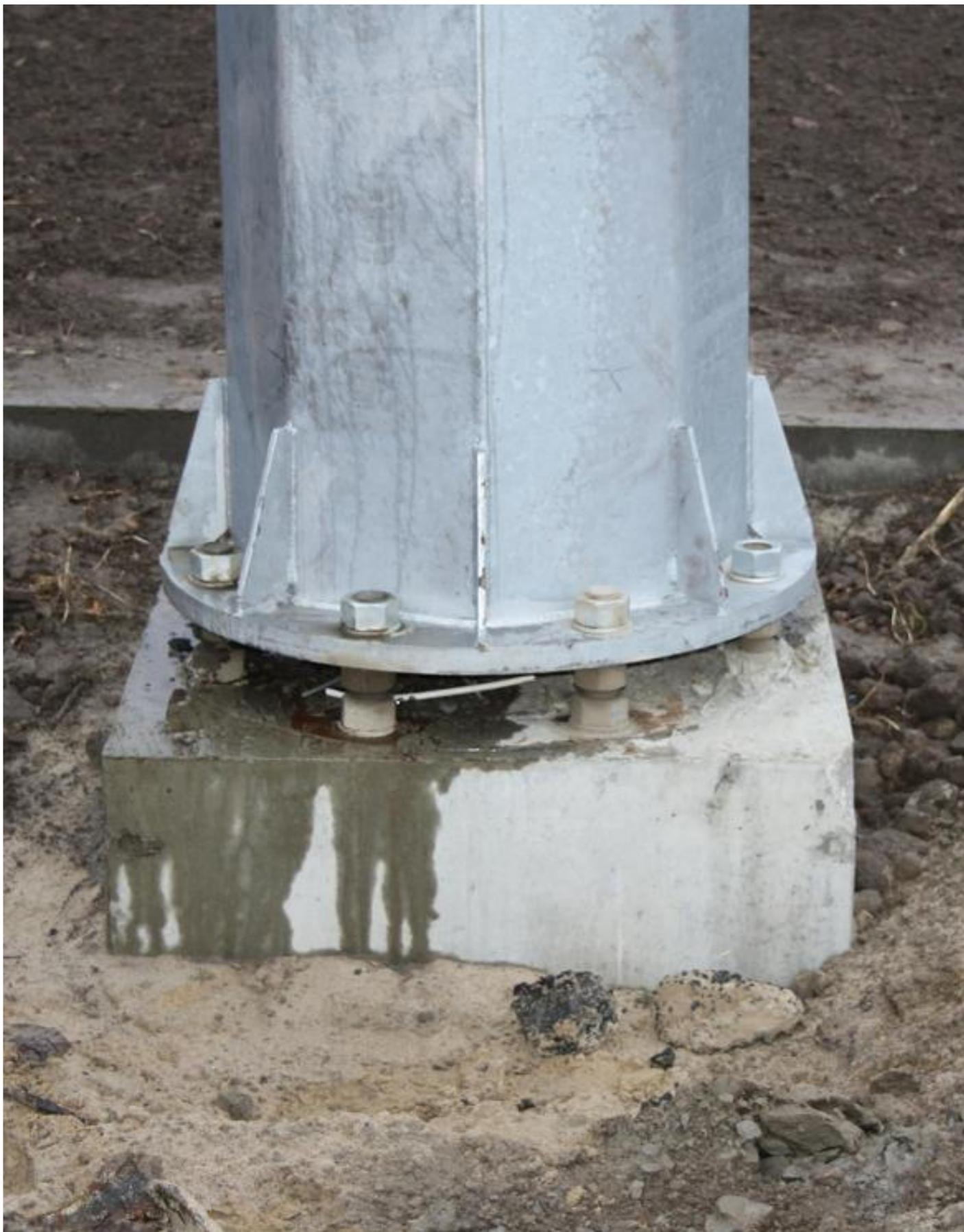
*Рис. 134. Бетонное основание и нижняя часть столба ОГСКС-2,3-10.*
