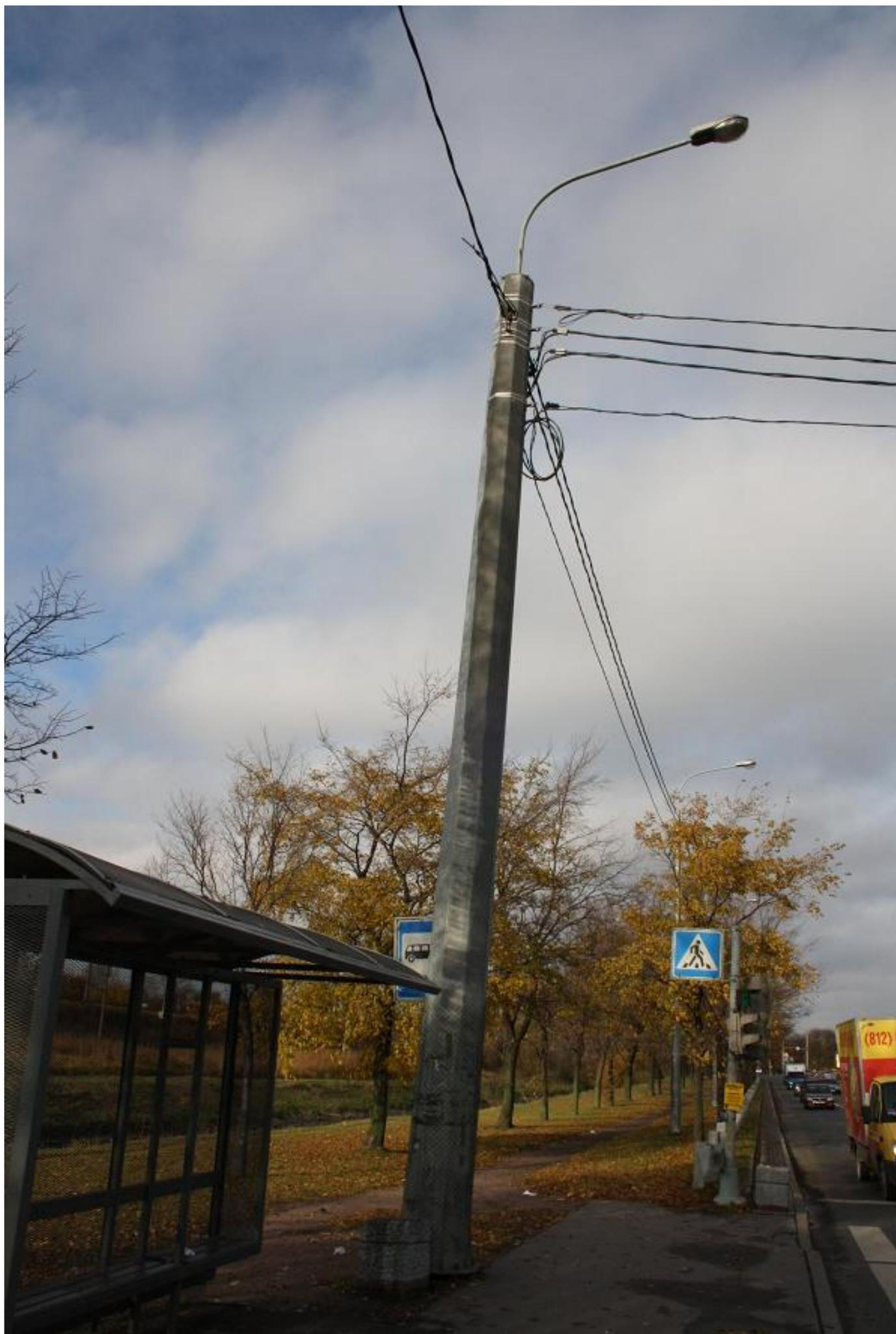
*Рис. 120. Толстенный столб ОГС 1,8-10М линии магистрального освещения. Белградская улица.*
