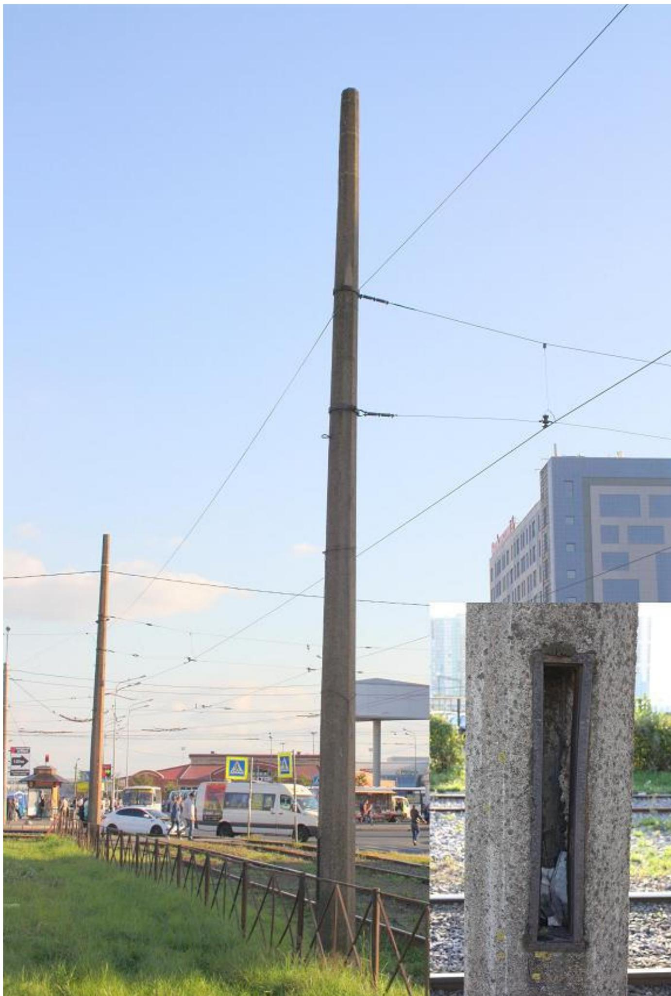
*Рис. 27. Бетонный столб типа «СВ» для улиц с электротранспортом. Ранняя версия.*
