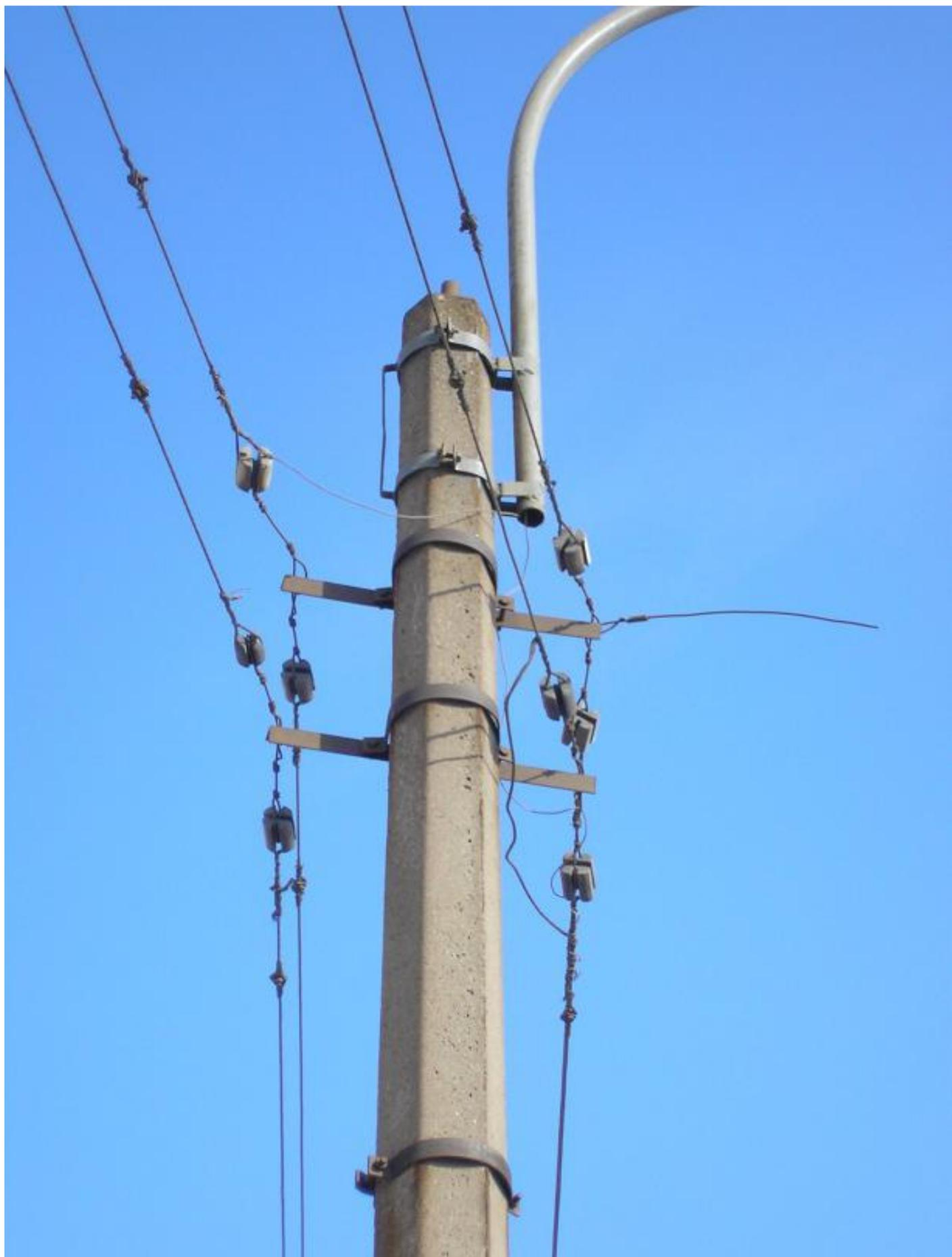
*Рис. 62. Консоль бокового крепления с гладкой скобкой и разные типы изоляторов на стальной проволоке.*
