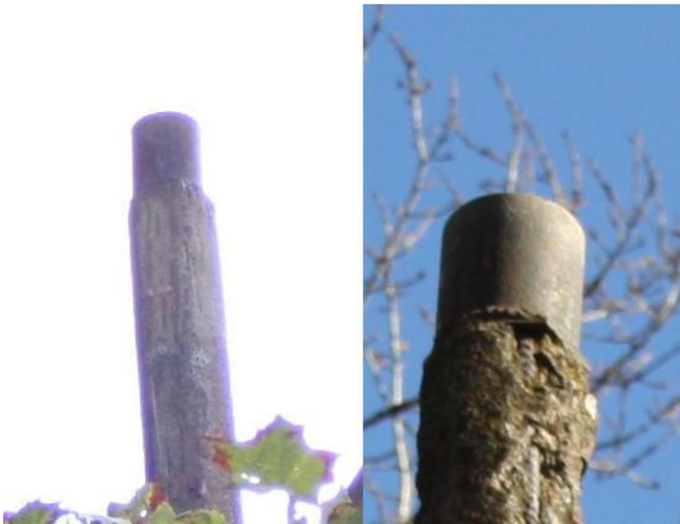
*Рис. 2. Широкий штырь бетонного столба первой версии. Нарезка из снимков. Крупный план.*
