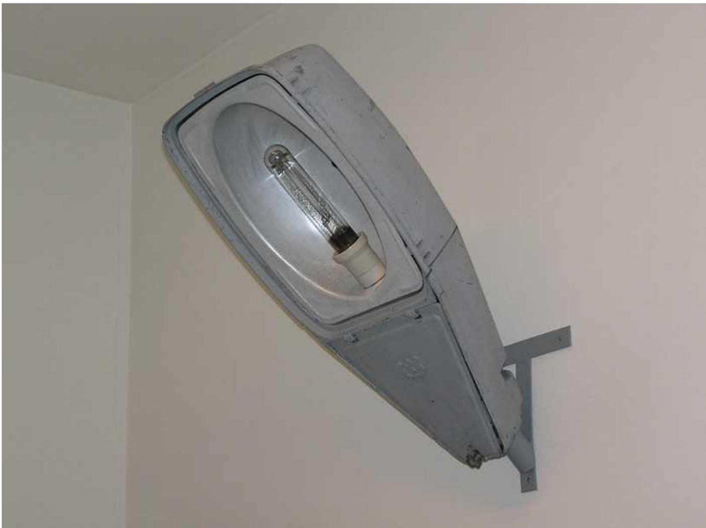
*Рис. 69. Светильник ЖКУ02-400-004 (Версия 2) 1987 год. Крупный план.*
