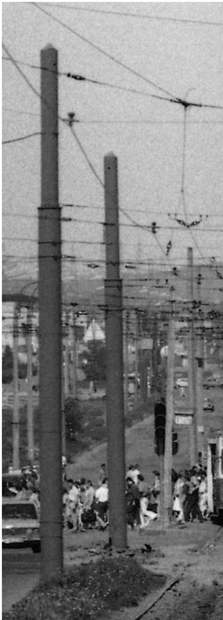
*Рис. 43. Толстый двухступенчатый металлический столб. Проспект Энгельса 1992 год.*
