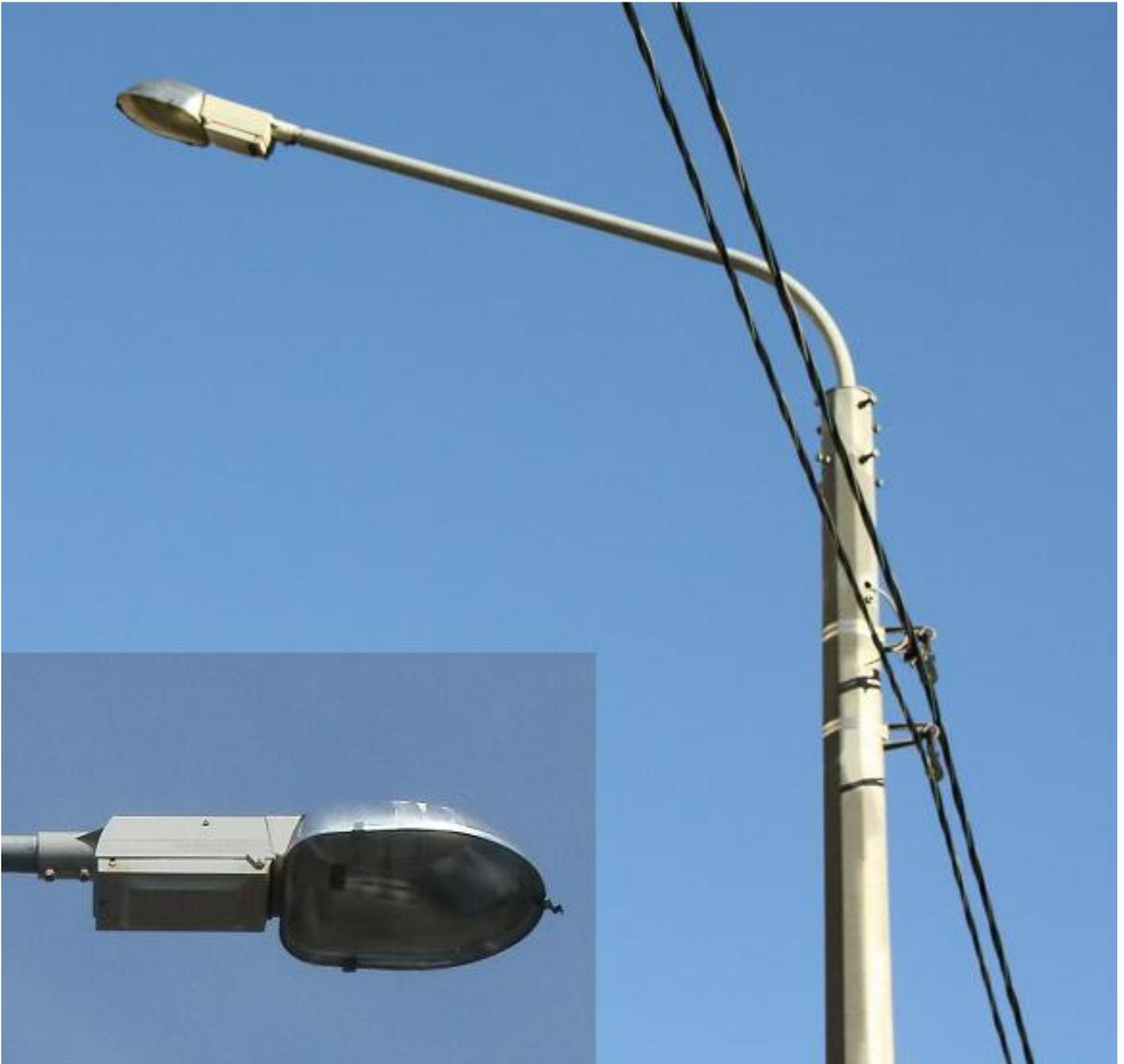
*Рис. 126. Светильник ЖКУ52-xxx-001 на линии освещения кармана. Проспект Славы.*
