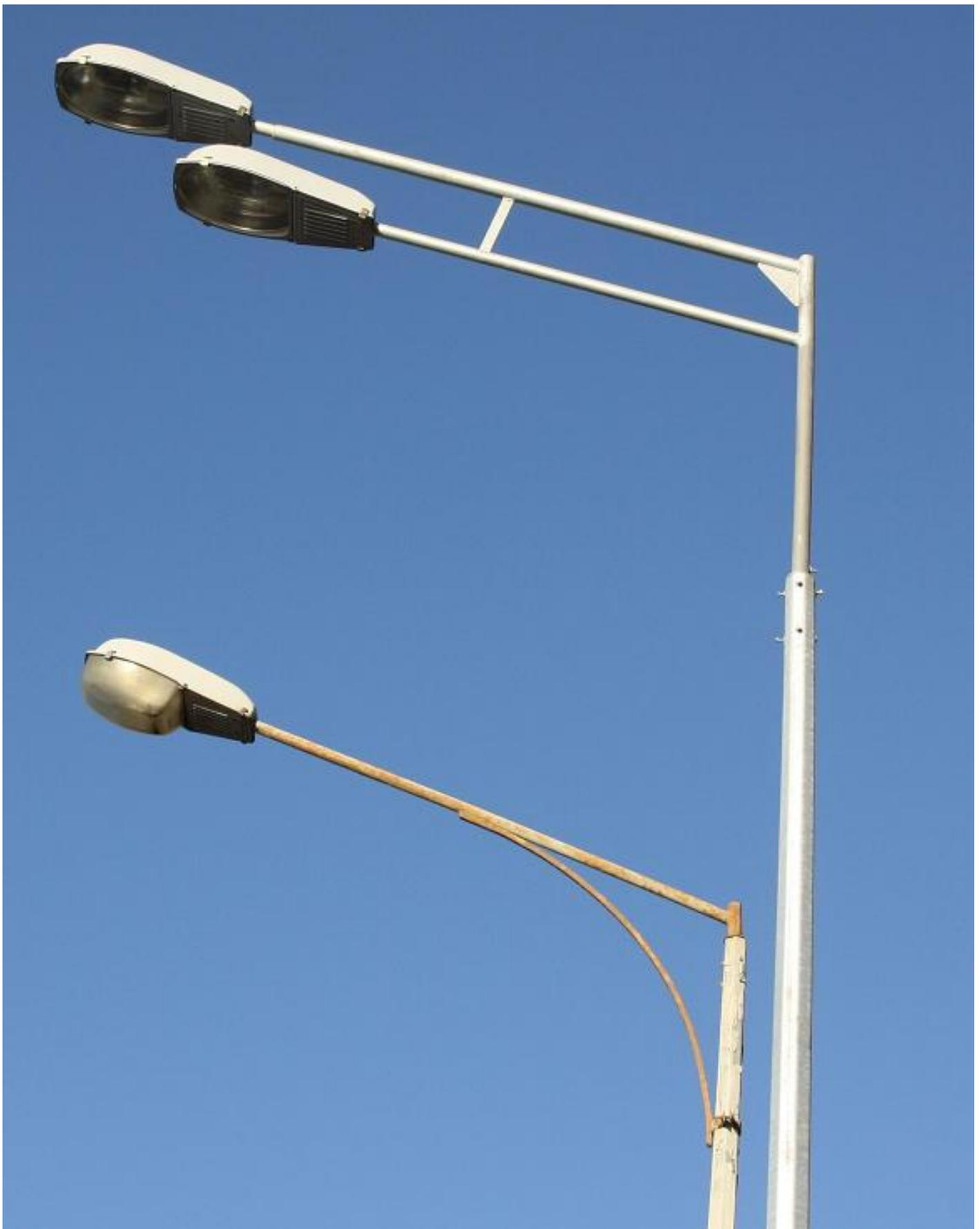
*Рис. 132. Реконструкция освещения на набережной (Малоохтинском проспекте). Старые и новые столбы со светильниками.*
