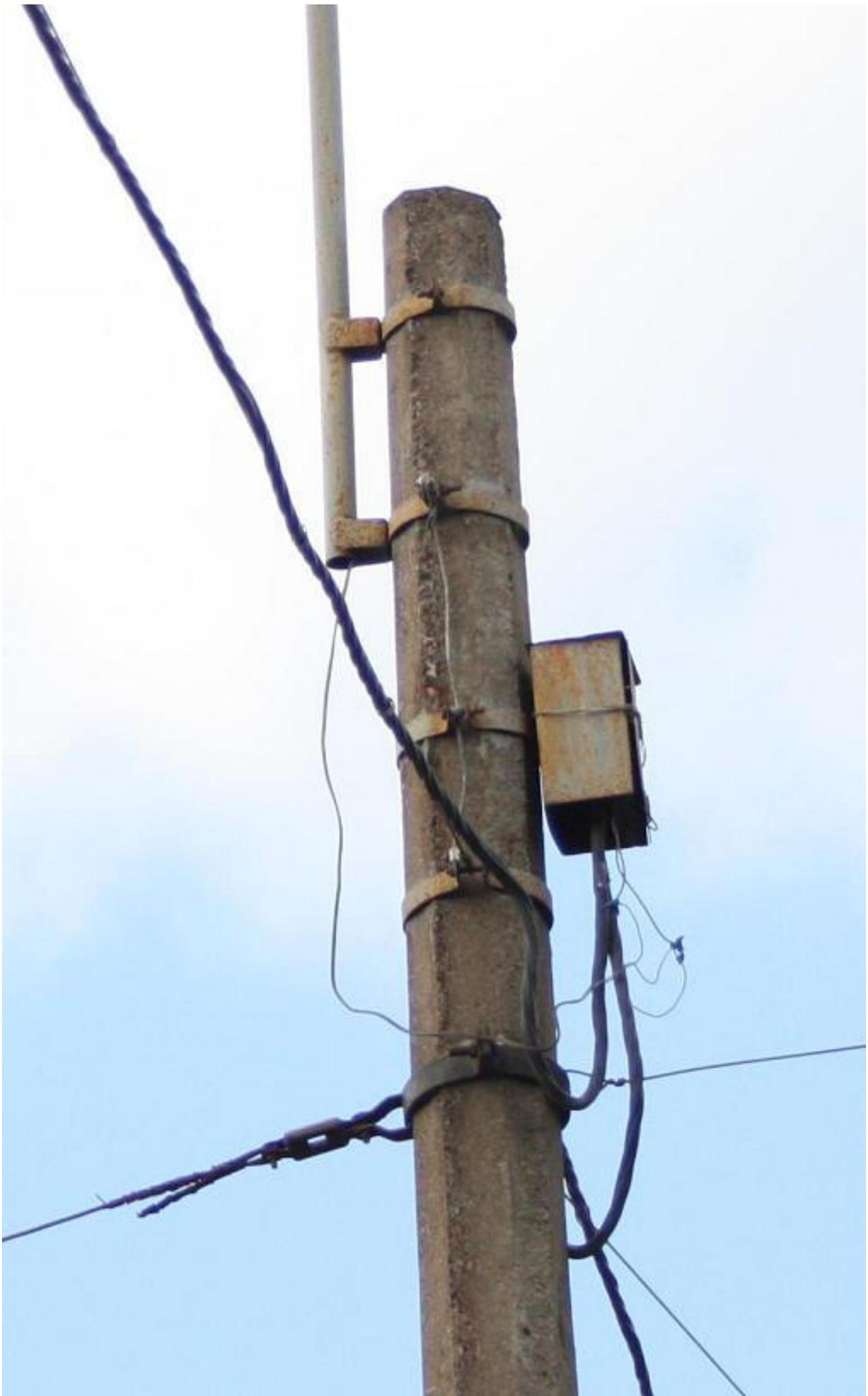
*Рис. 98. Распределительная коробка на кабельной линии магистрального уличного освещения 2-й половины 1990-х годов.*
