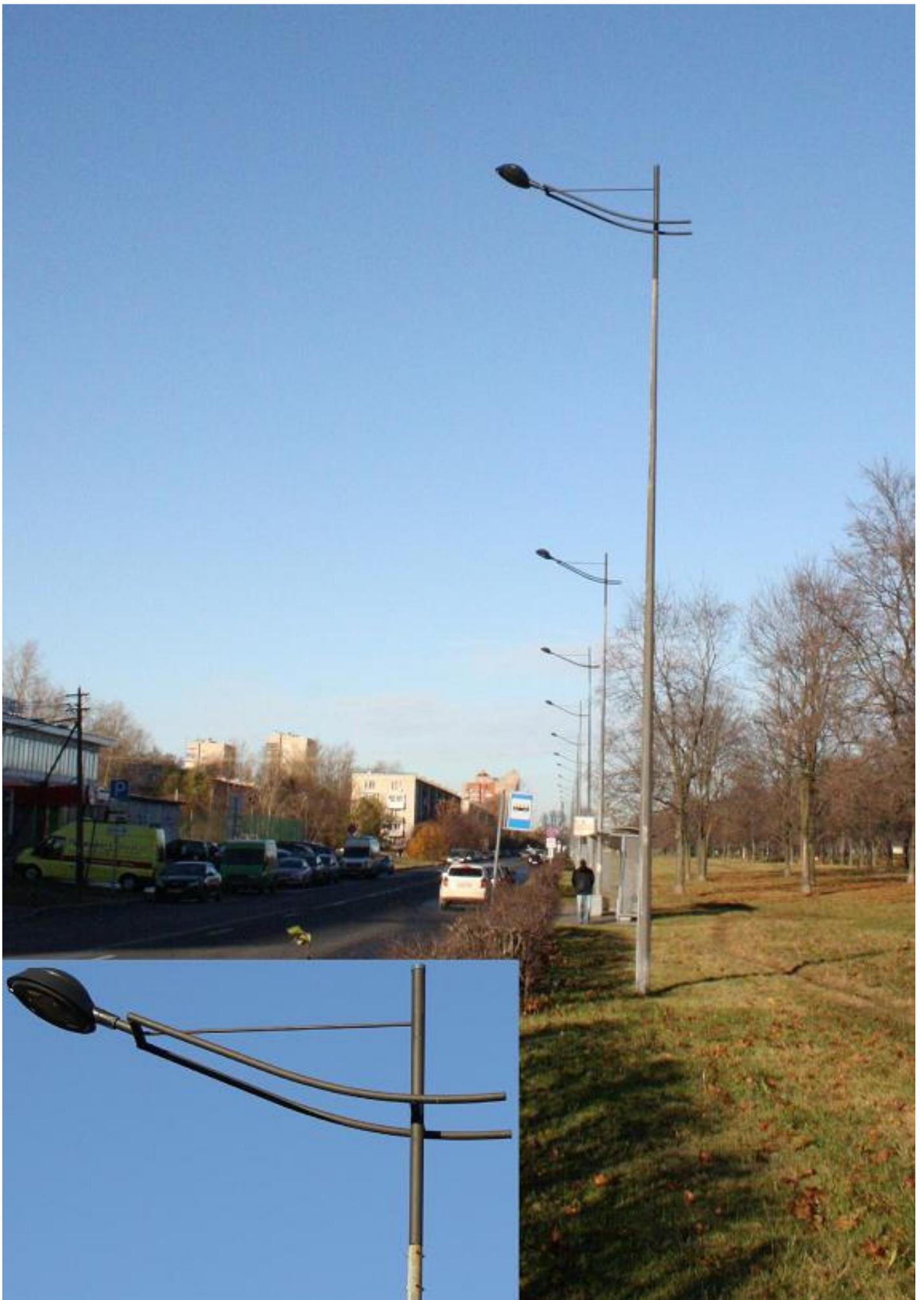
*Рис. 110. Линия магистрального освещения с подземным вводом на Витебском проспекте.*
