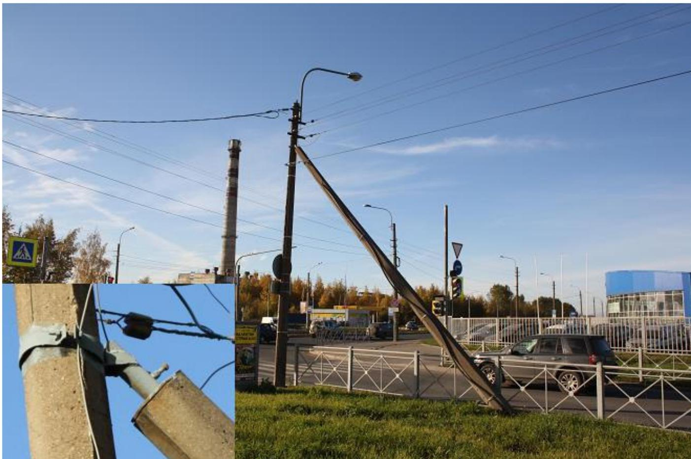
*Рис. 59. Узел соединения подпорки со столбом, сделанный из «СВ со штырьком» образца 1970-х годов.*
