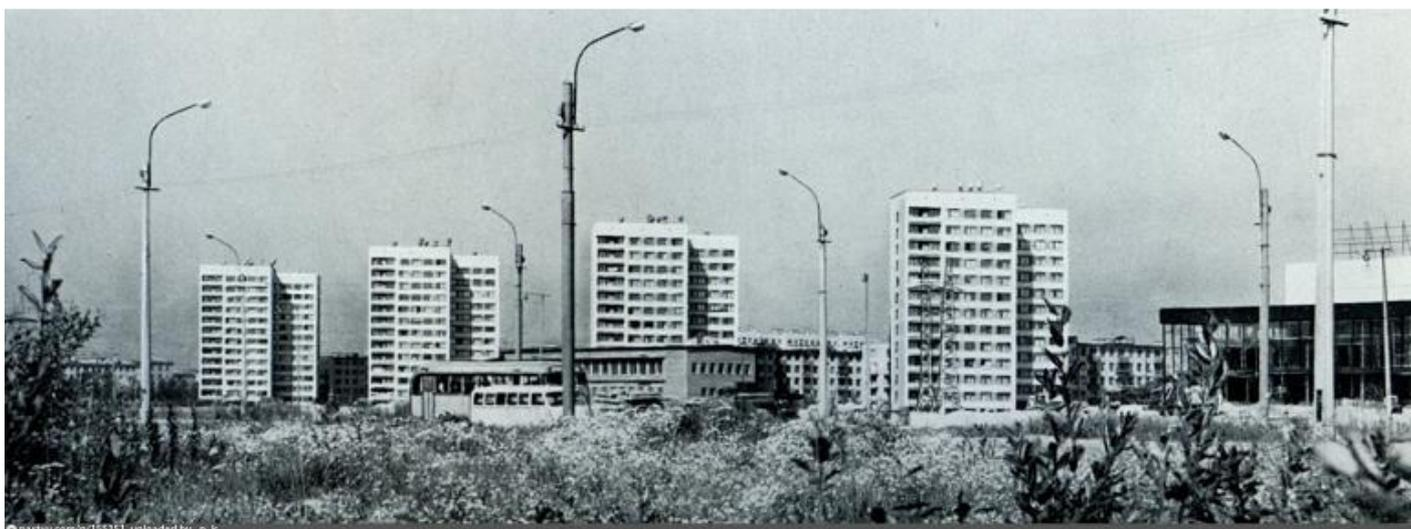
*Рис. 28. Совмещенная линия освещения и контактной сети. Улица Тупанова. Конец 1960-х – начало 1970-х.*
