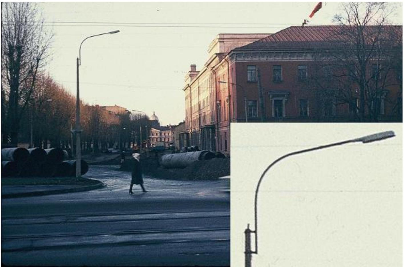
*Рис. 61. Консоль бокового крепления со скобкой на тонком столбе со штырем. Введенский канал 1978 год.*
