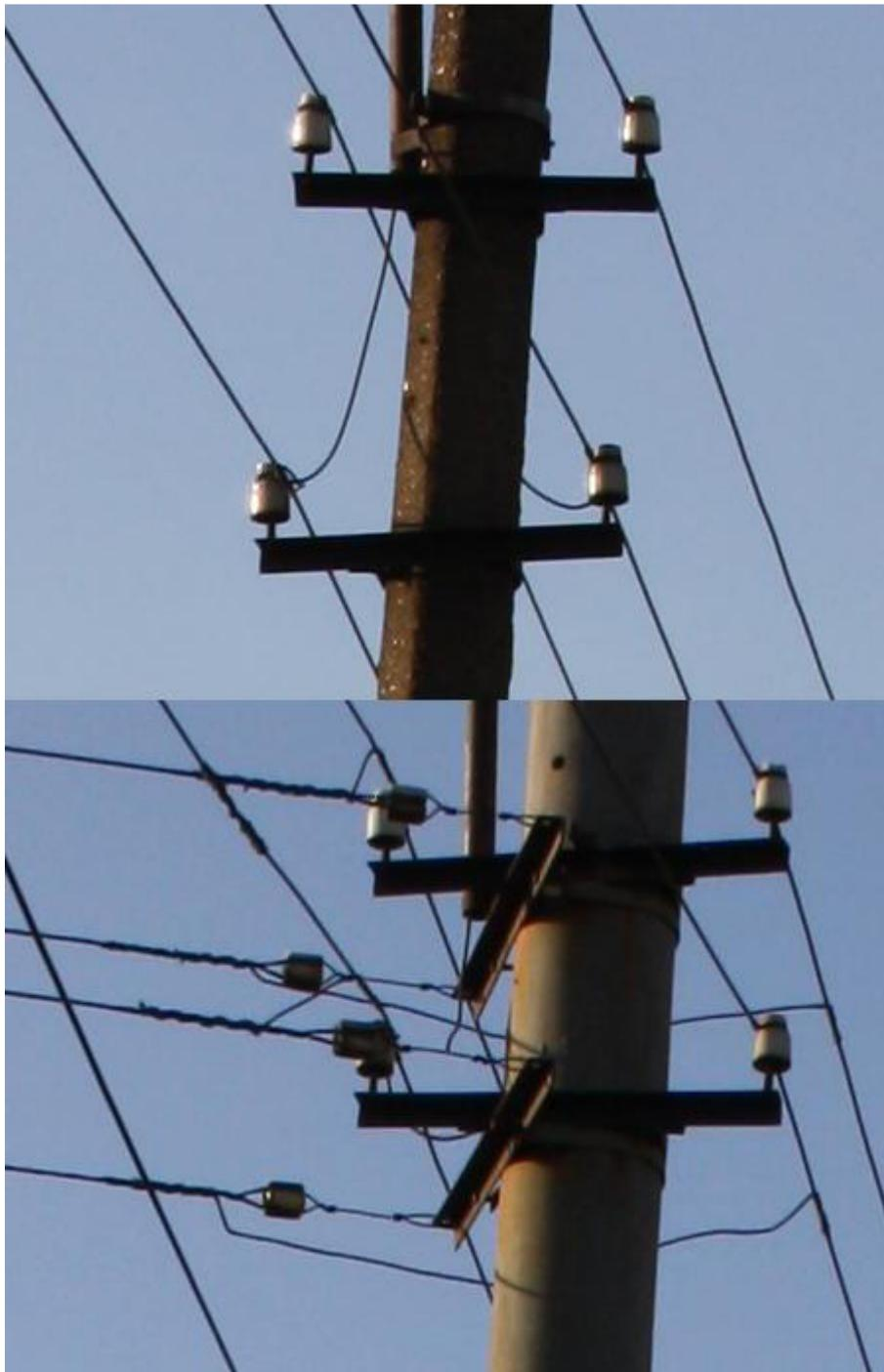
*Рис. 51. Крупный план расположения проводов «квадратом» на проходном столбе и с ответвлением.*
