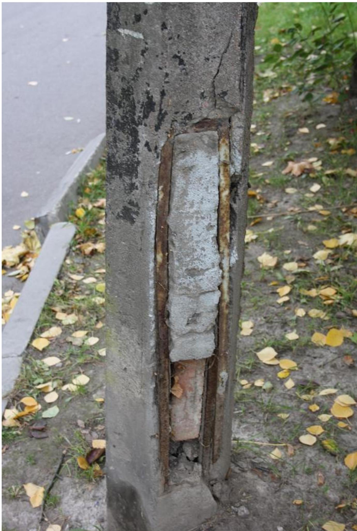
*Рис. 22. Дырка в столбе заделанная кирпичами и бетоном.*
