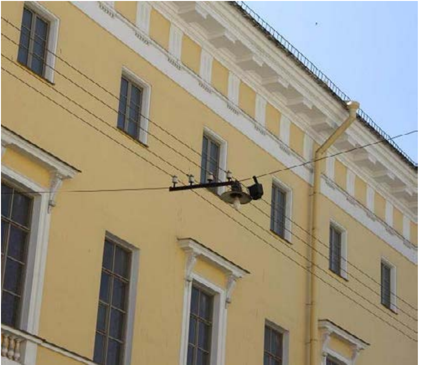
Рис. 73. Подвес с СПО-200 и лампой ДРЛ 250 на растяжке крупным планом. 8 августа 2015 года.
