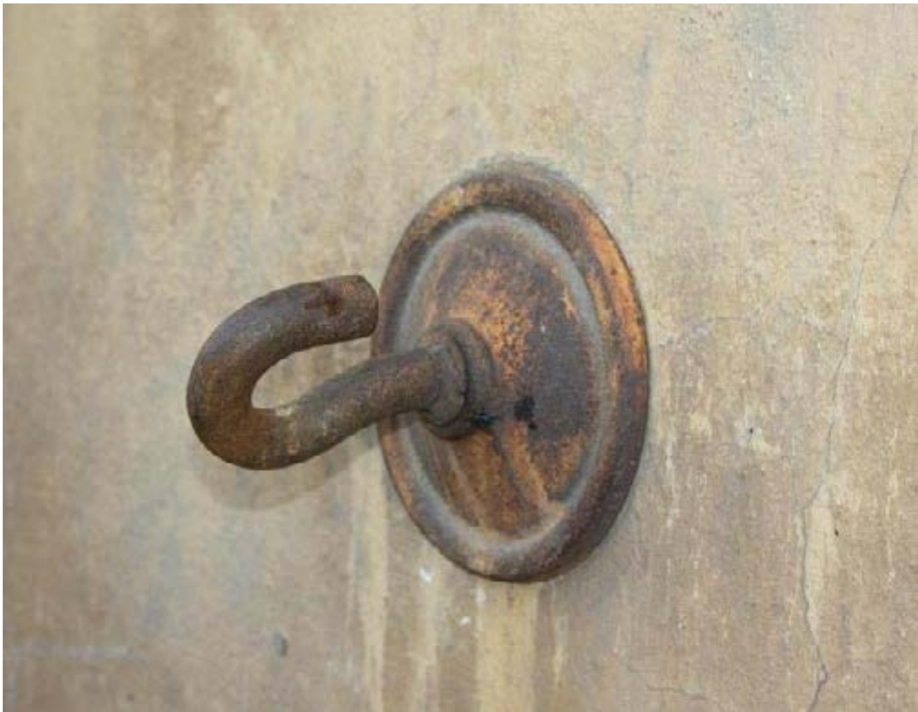
Рис. 14. Анкерный крюк с шайбой типа «Присоска» вбитый в стену. Крупный план.
