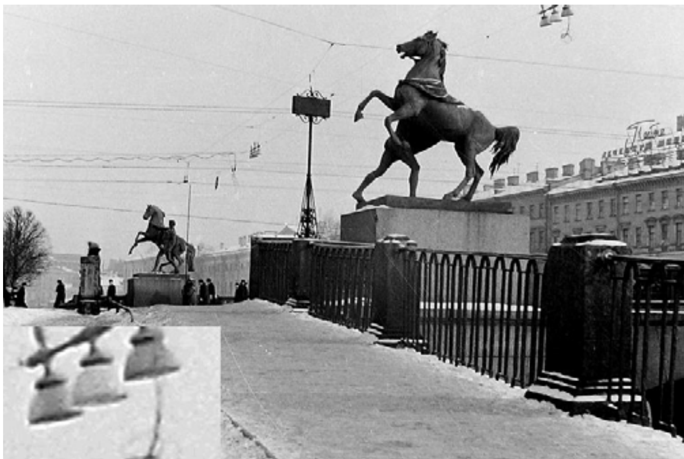
Рис. 65. Обновленные плафоны в люстрах Аничкова моста. Подсоединение титания. 1961 год.
