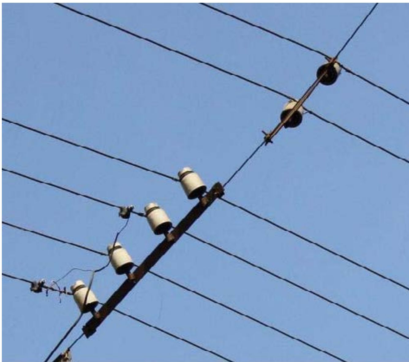
Рис. 106. Рамки с изоляторами нового образца. Отклонение от вертикального положения. Крупный план.
