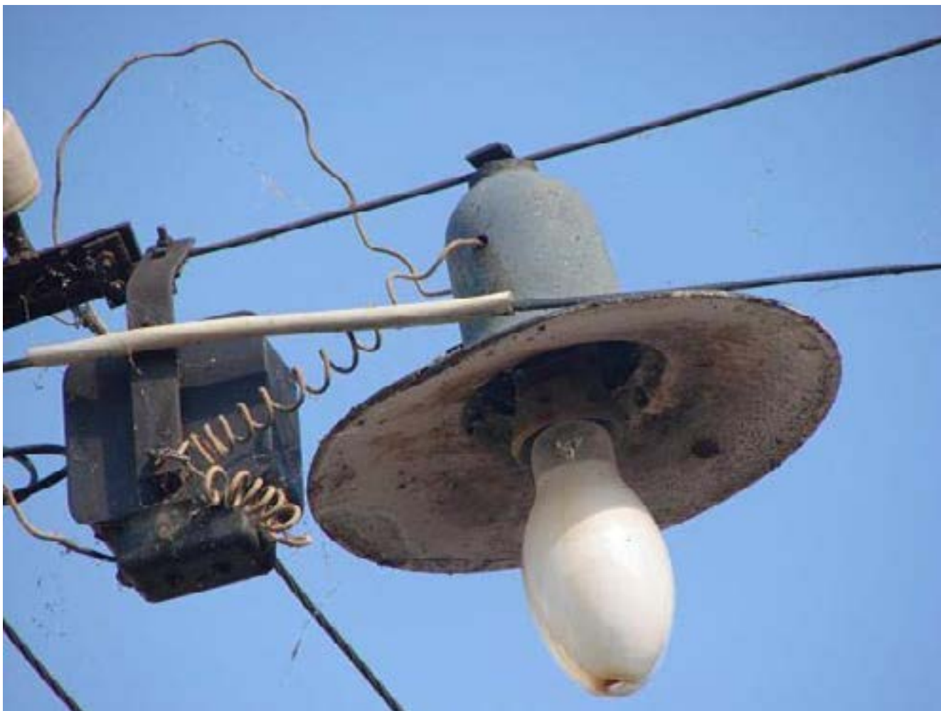
Рис. 74. Прокачанный СПО-200 с ДРЛ 250 и пускорегулирующим аппаратом типа ДБИ. 11 августа 2014 года.
