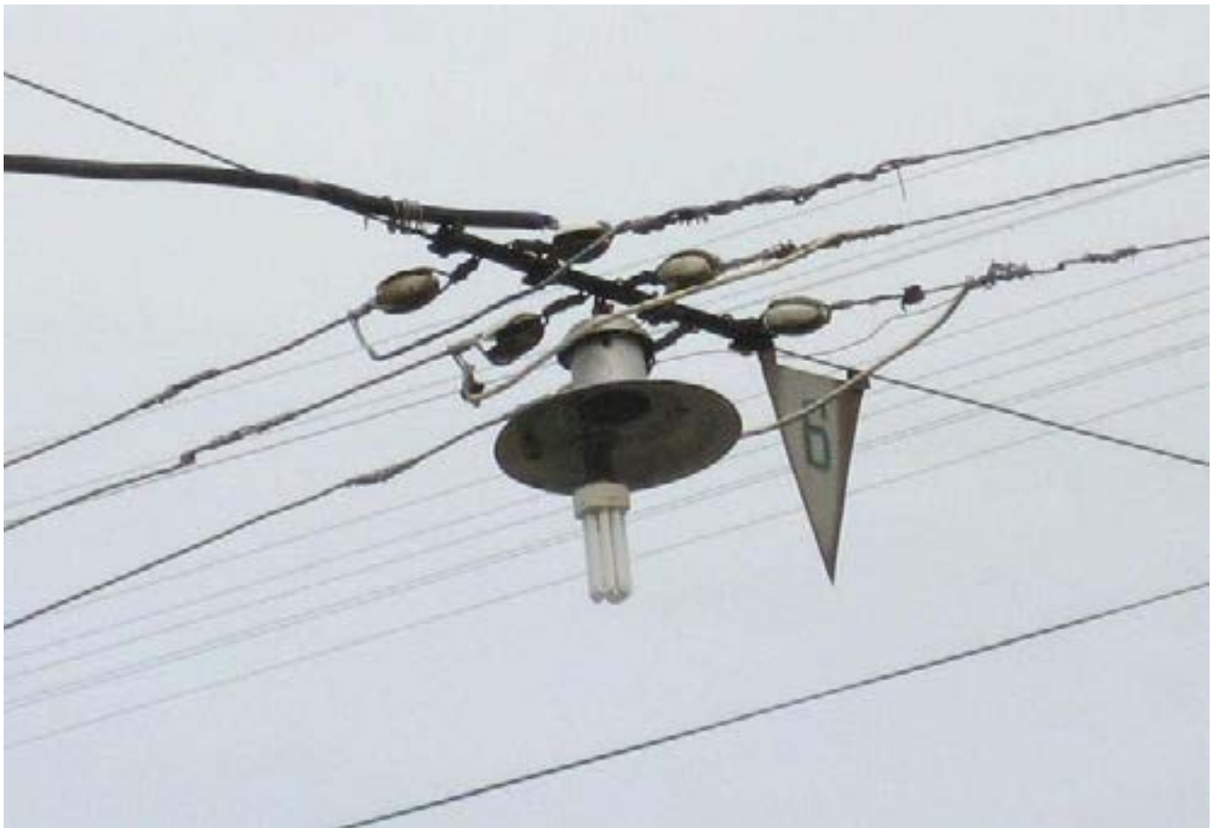
Рис. 9. Типовая проходная растяжка на такелажных изоляторах довоенного и послевоенного времени.
