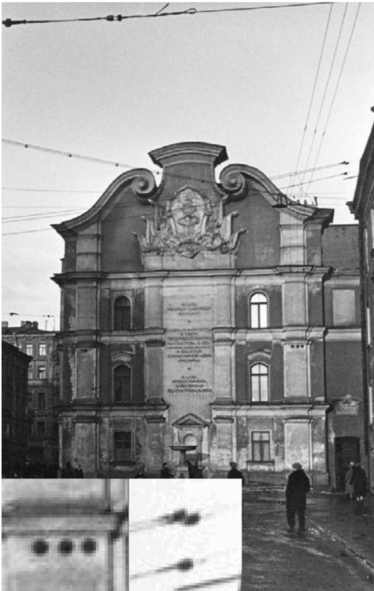
Рис. 16. Поворот линии на изломе улицы, при помощи большого количества «присосок». Улица Пестеля.
