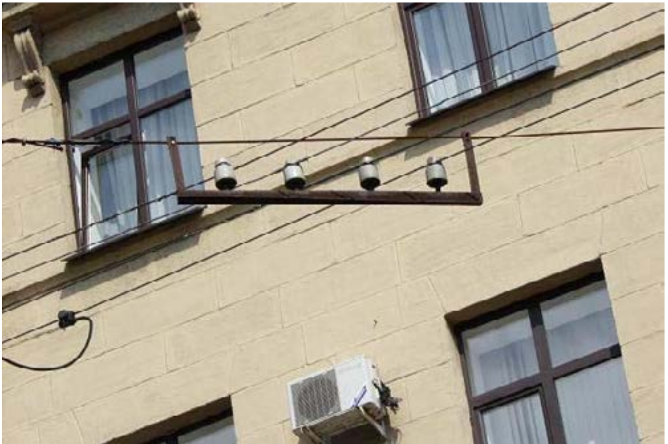
Рис. 87. Типовая подвеска для проводов середины 1970-х из сварного каркаса. Вариант 2 с ребром жесткости внизу.
