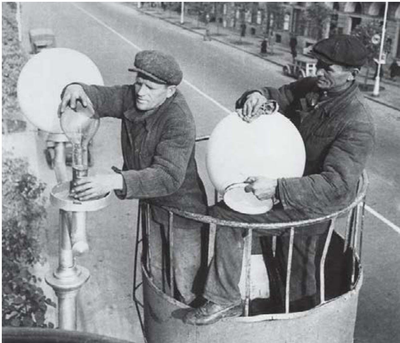
Рис. 37. Замена лампы в шарообразном светильнике на опоре «Индустриальной» версии. Улица Бродского (фотография из книги «Летопись Ленсвета»).
