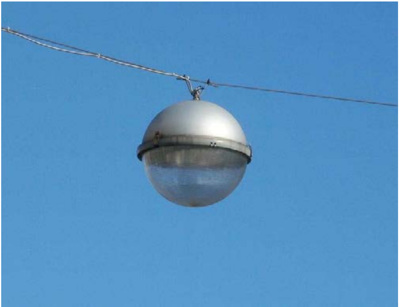
Рис. 136. Светильник ЖСУ19-xxx-001 на растяжке.
