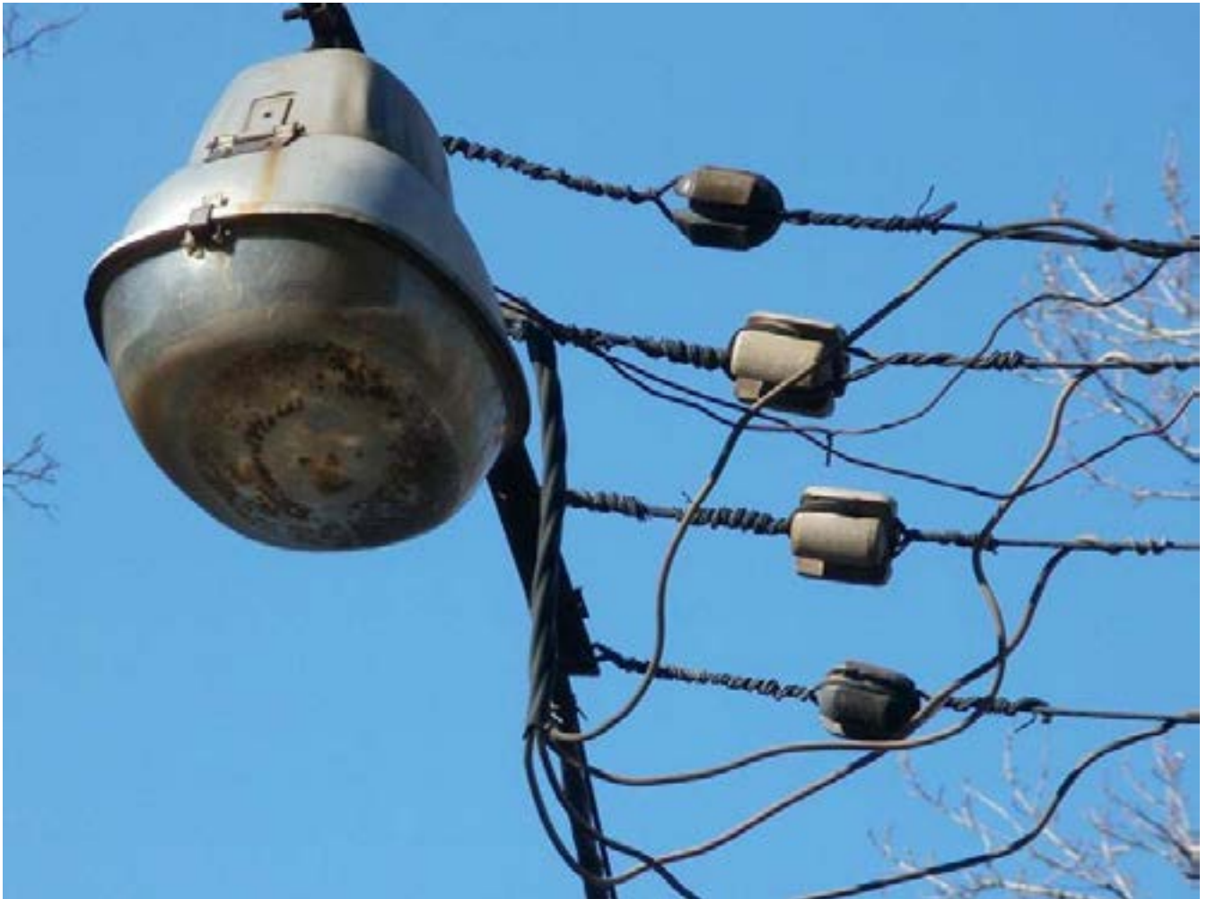
Рис. 51. Полоса с разными такелажными изоляторами на медном тросе типа М16. 28 марта 2013 года.
