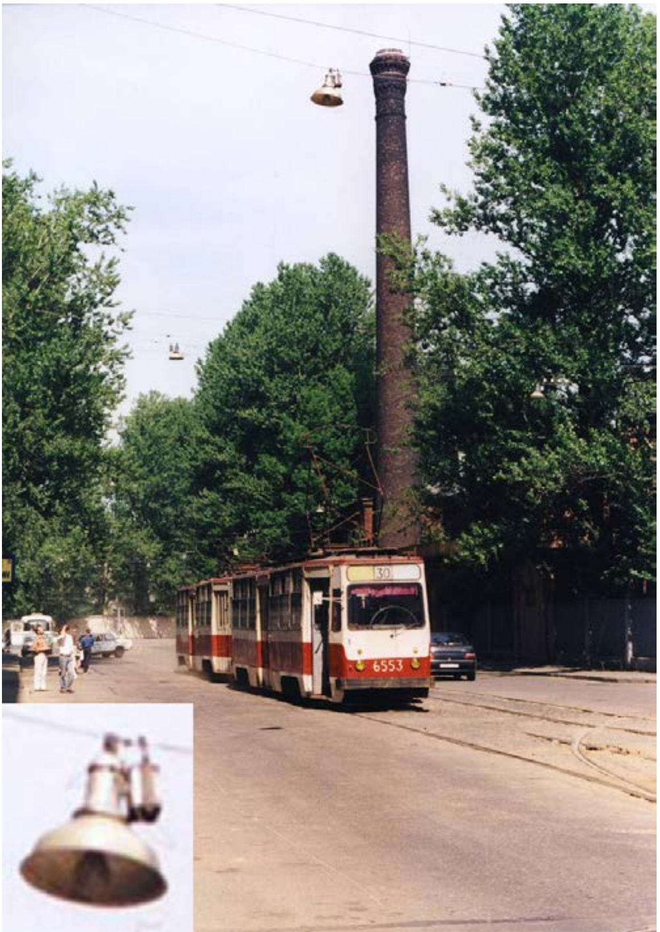
Рис. 92. Светильник «Миска» в.1 на базе чугунного колокола СПУ-300 и румынским дросселем ВУА. Барочная улица. 12 июня 1996 года.
