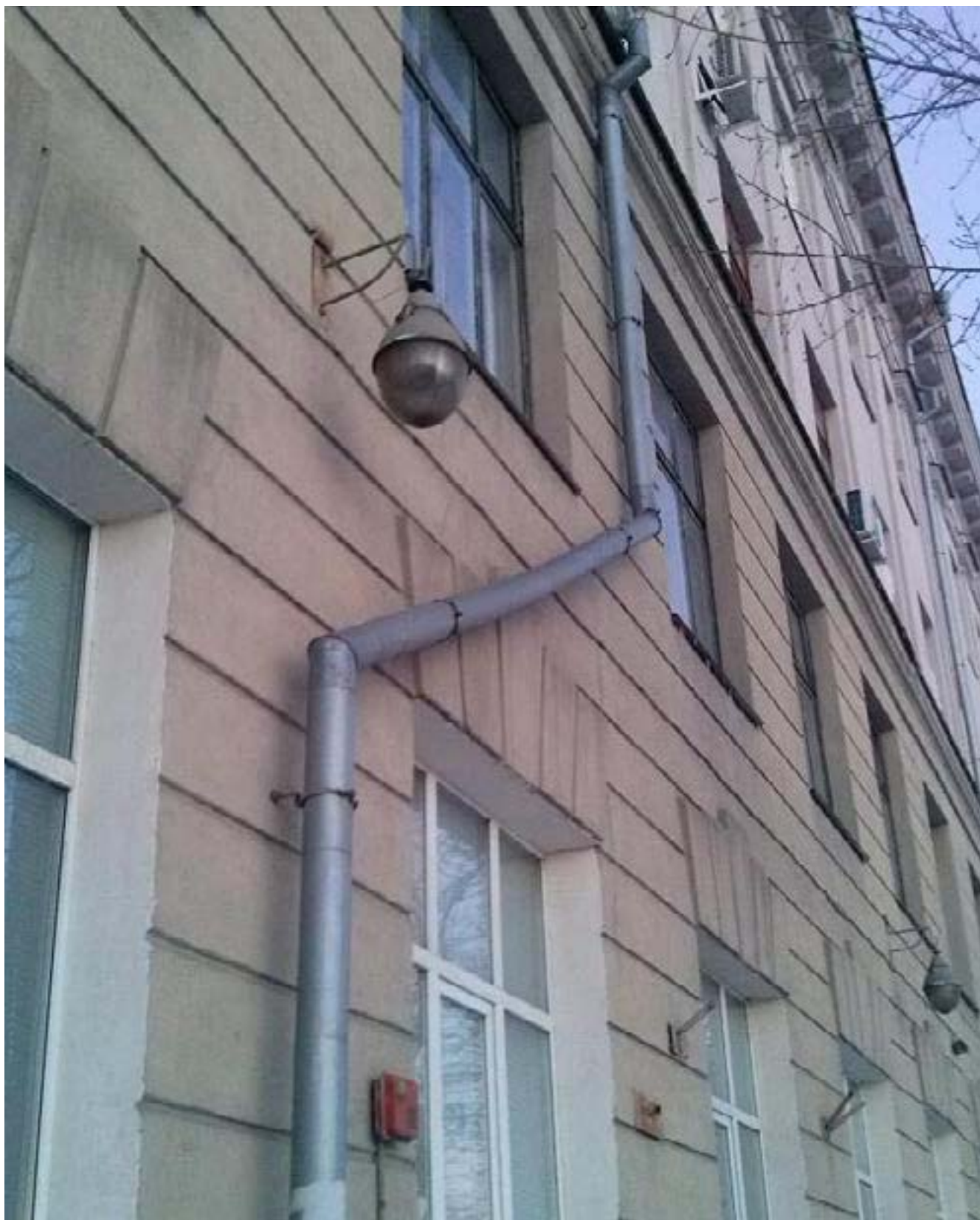
Рис. 42. Каплевидный светильник СПЗ крупным планом.
