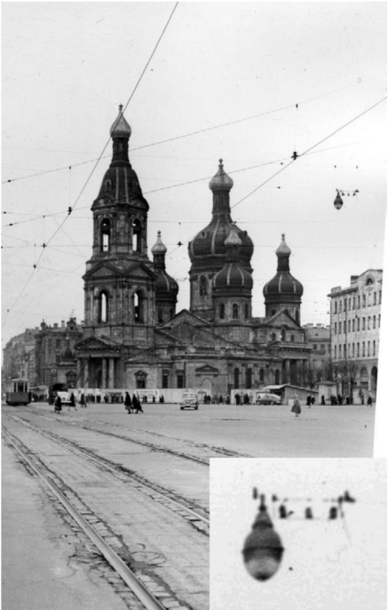
Рис. 41. «Шишкообразные» каплевидные светильники СПЗ версии 1950-х годов. Сенная площадь 1960 год.
