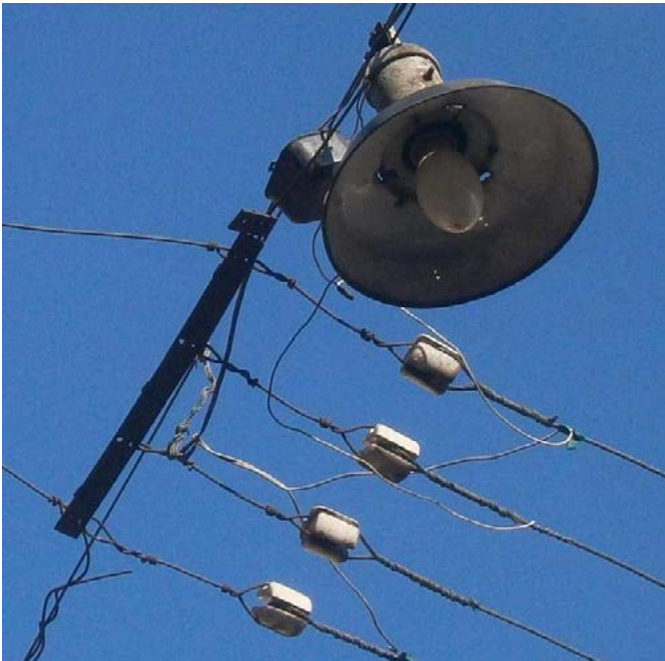
Рис. 96. Светильник «Миска» v.2. Вид снизу. Крепление отражателя.
