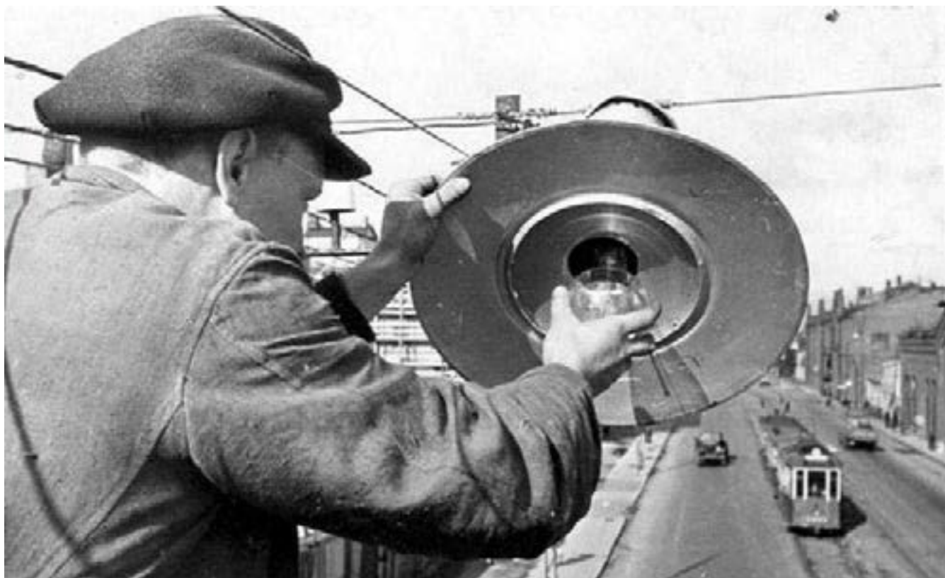
Рис. 21. Электрик вкручивает лампу в светильник на растяжке уличного освещения. Проспект Обуховской Обороны. 16 сентября 1946 года.
