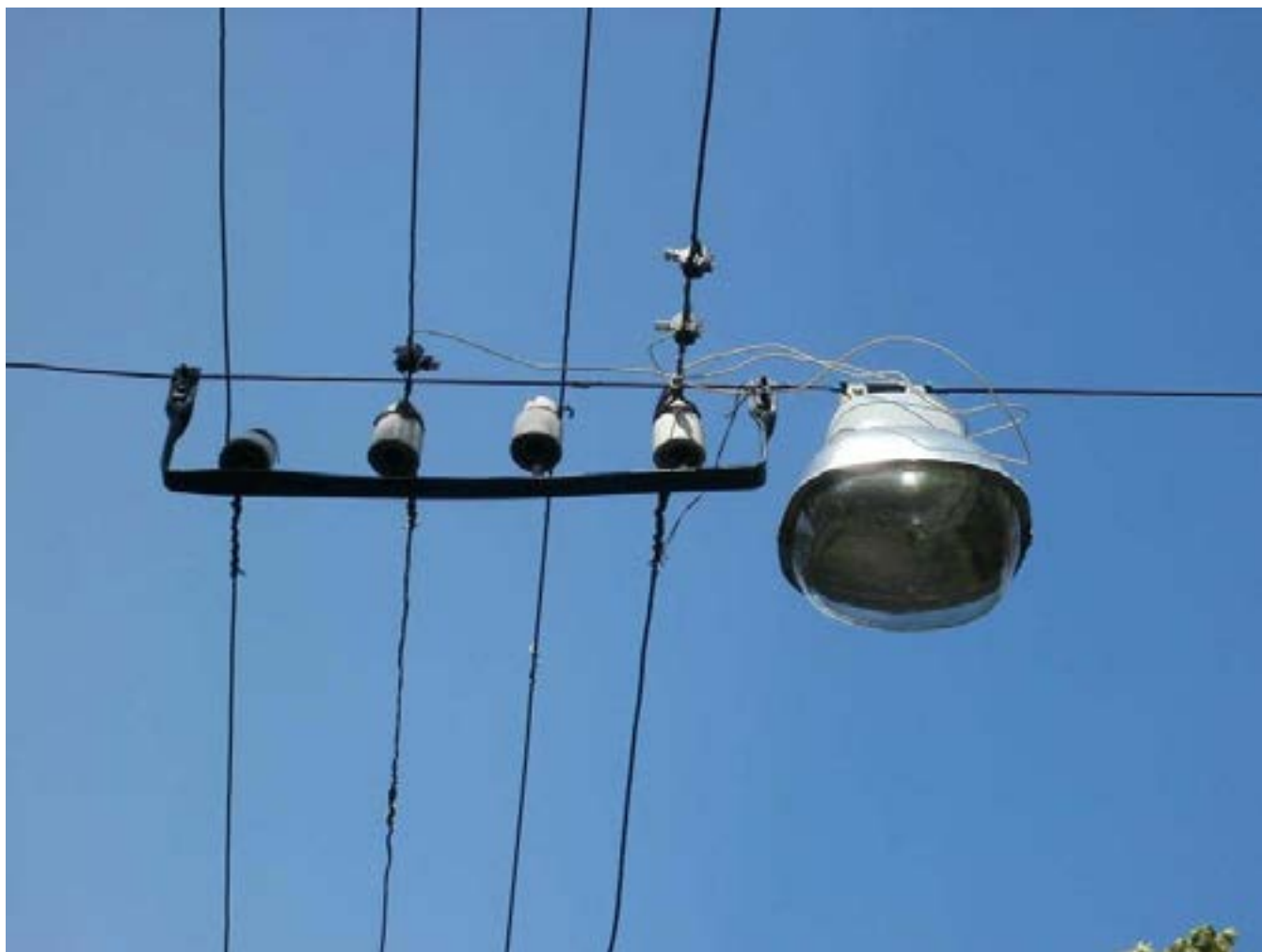
Рис. 6. Четырехпроводная конструкция растяжки уличного освещения с внутренним расположением проводов. Крупный план.
