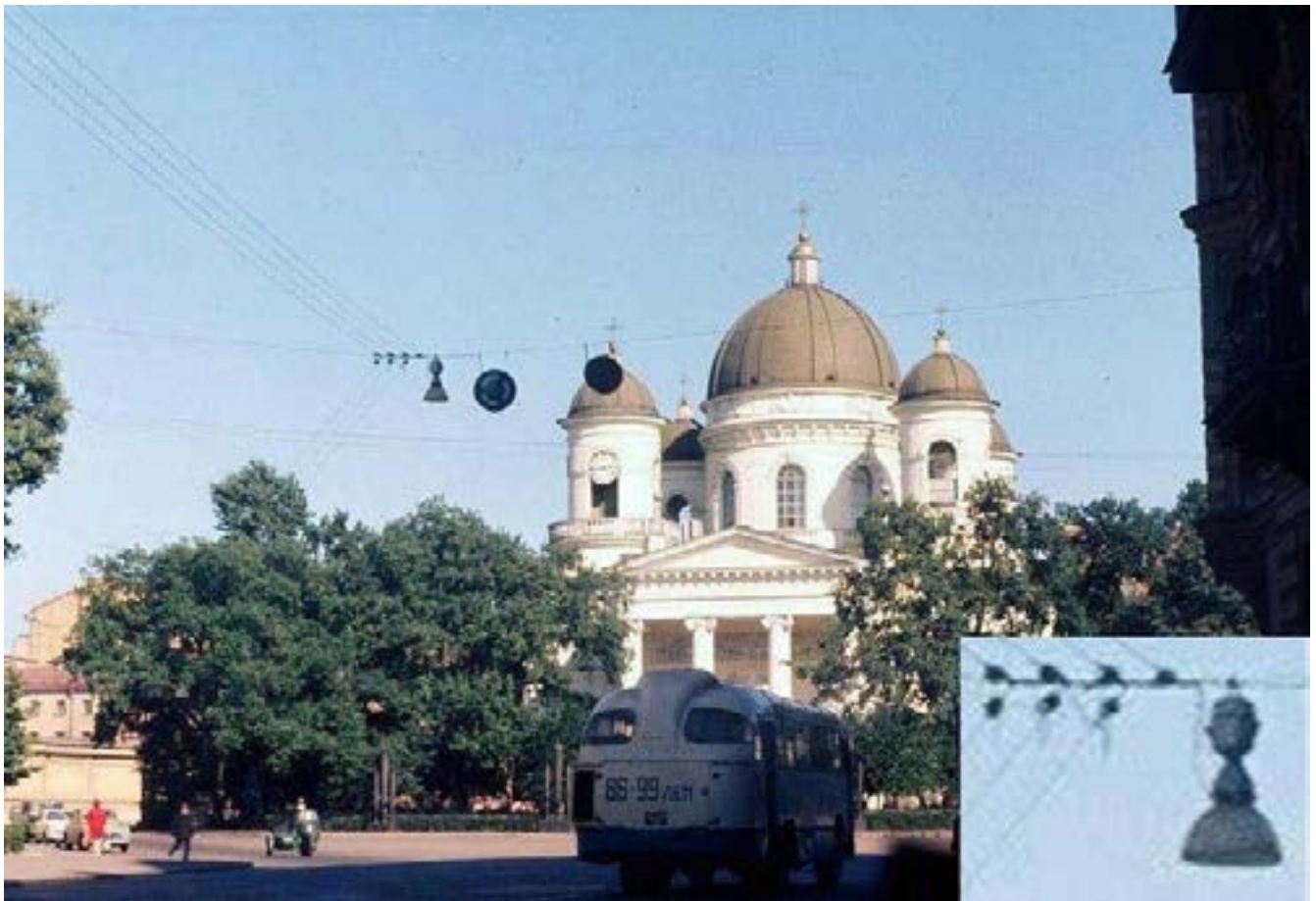
Рис. 77. «Ранний Ленинградский Псевдо-СПОР». «Шишкообразный» светильник под лампу ДРЛ доработанный стеклом от СПО-1000. Улица Пестеля 1970 год.
