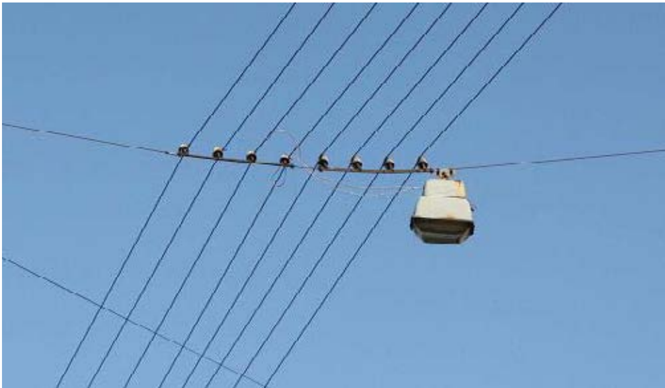
Рис. 108. Восьмипроводная сеть крупным планом.
