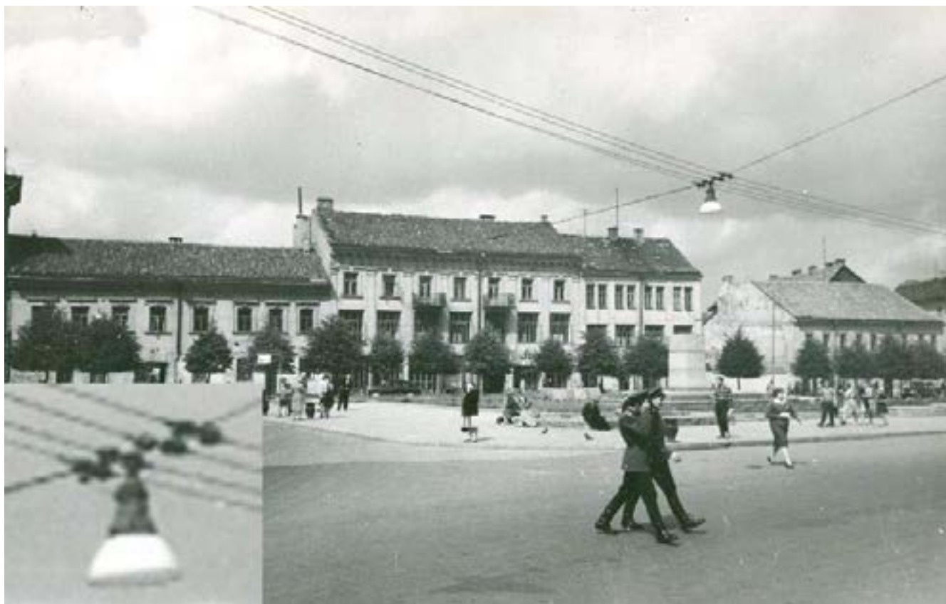
Рис. 59. Растяжка с СПО-1000 и близко прикрученными такелажными изоляторами. Вильнюс 1961 год.
