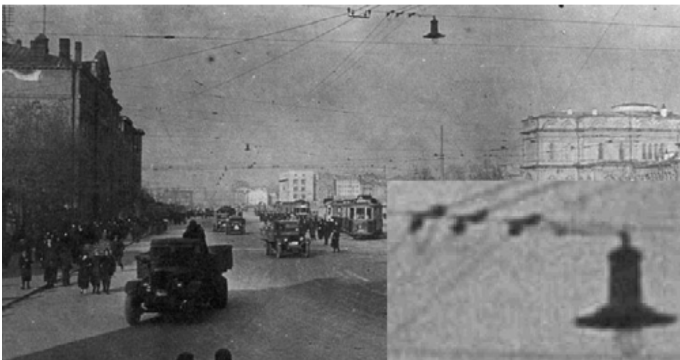
Рис. 8. Трехпроводная линия освещения с такелажными изоляторами. Московский проспект 1935 год.
