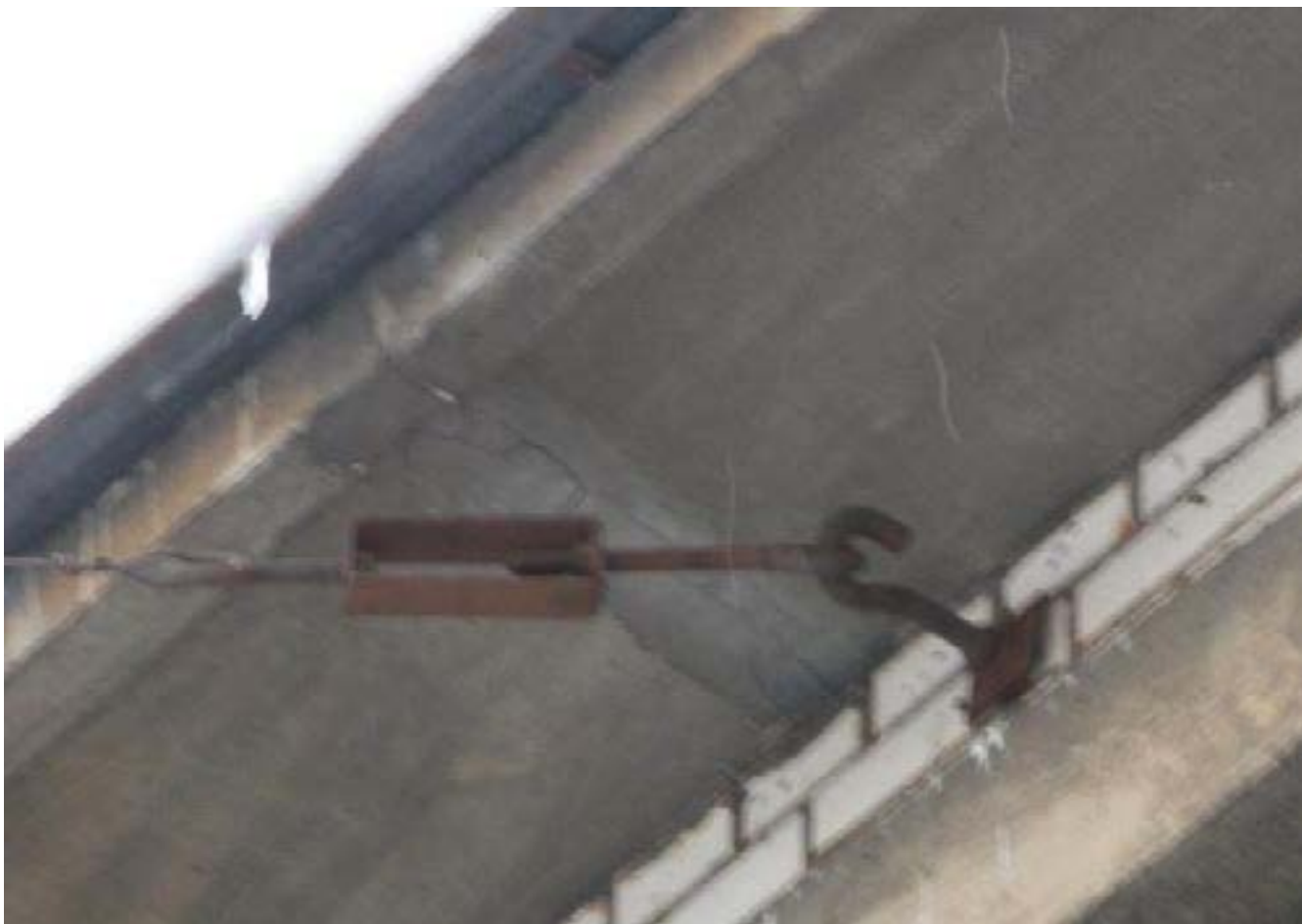
Рис. 119. Узел крепления проволоки на анкерном крюке с квадратной шайбой.
