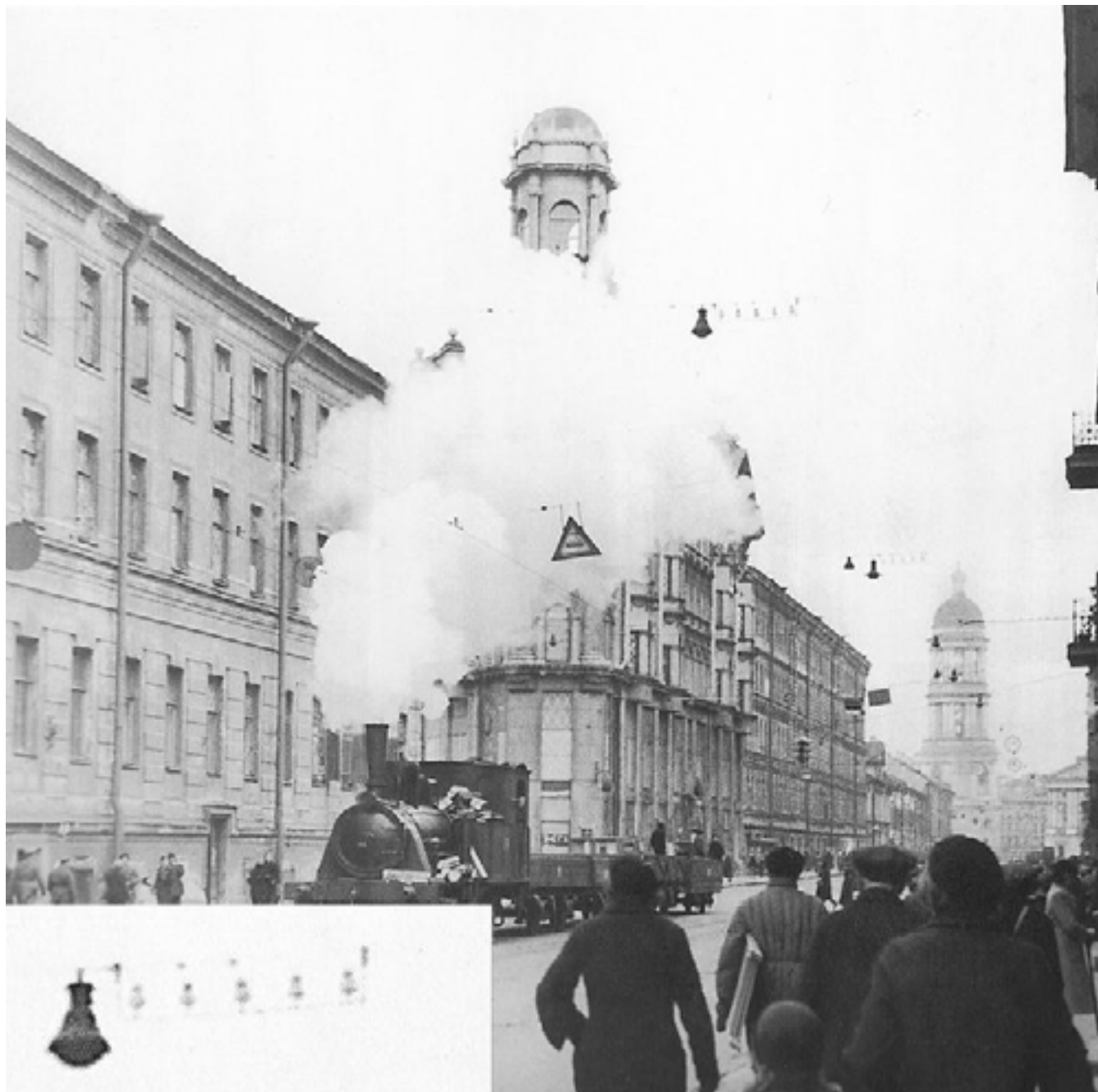
Рис. 2. Типичное пятипроводное довоенное освещение. Загородный проспект 1942 год.
