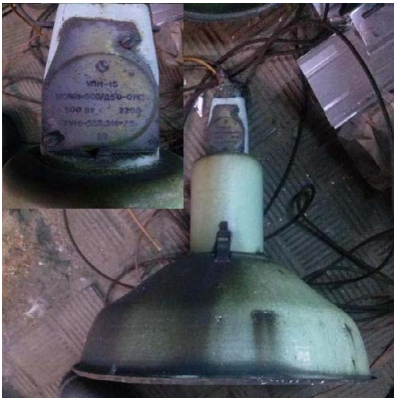
Рис. 93. Светильник УПМ-15 НСП01-500/Д50-01У3 и его клеймо крупно.
