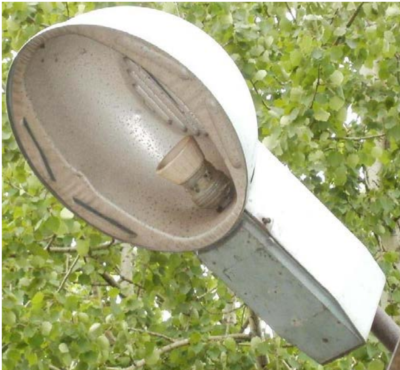
Рис. 121. Доработанный светильник ЖКУ07 с патроном E40 старого образца, на примере версии 2.
