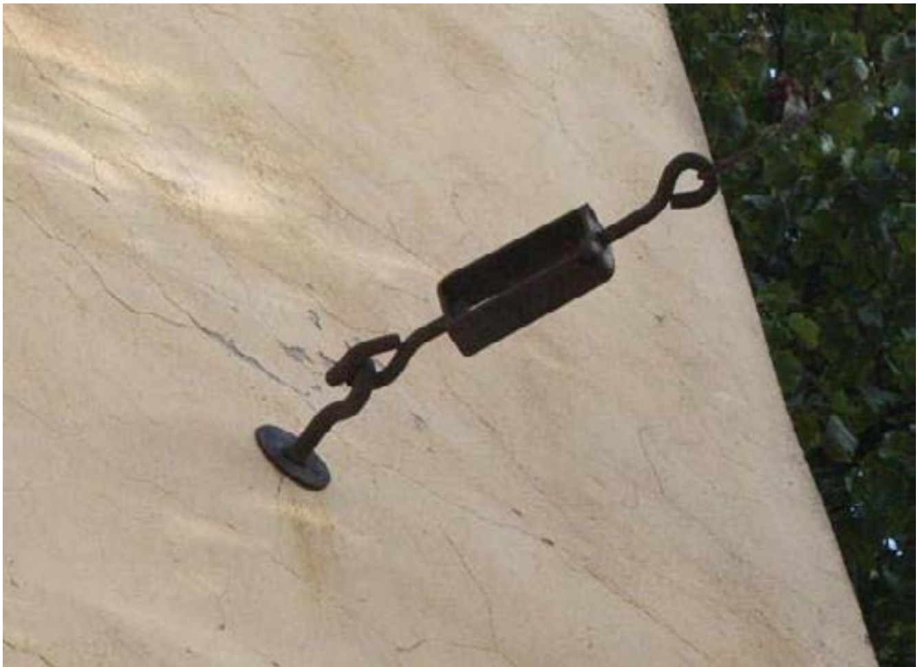
Рис. 138. Присоска с упрощенной шайбой образца 2000-х годов.
