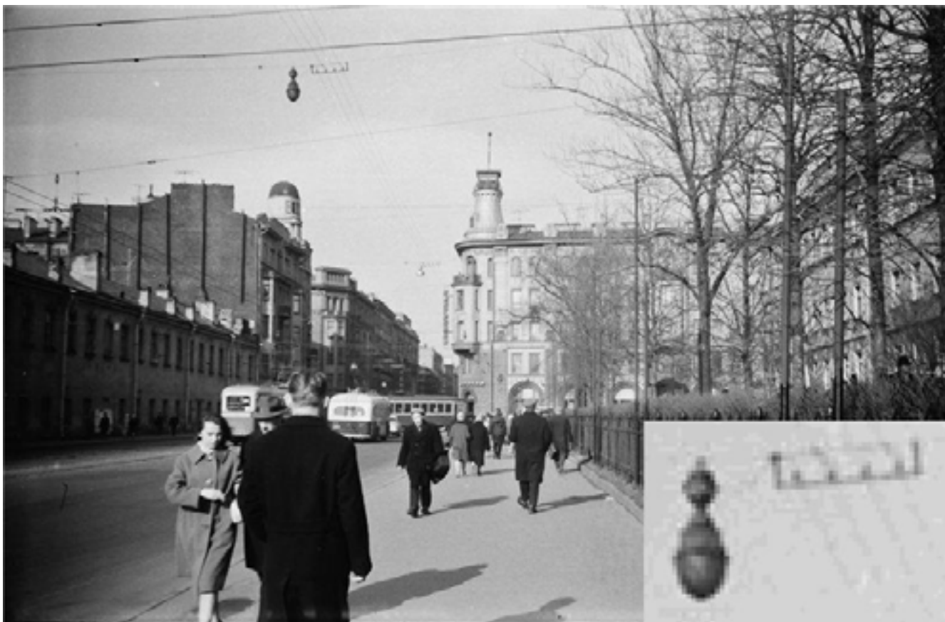
Рис. 75. «Шишкообразный» светильник со встроенным дросселем для ламп ДРЛ. Загородный проспект. 1960-е годы.
