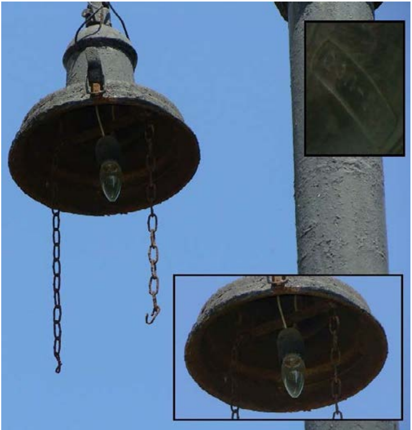
Рис. 31. Ошметки светильника СЗП-500.
