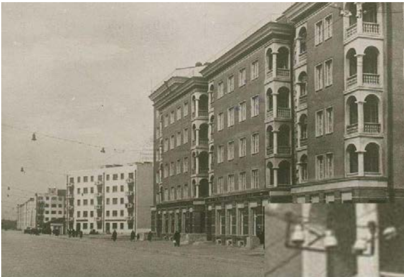
Рис. 4. Типичная трехпроводная сеть подвешного уличного освещения. Улица Седова 1939-1941 год.
