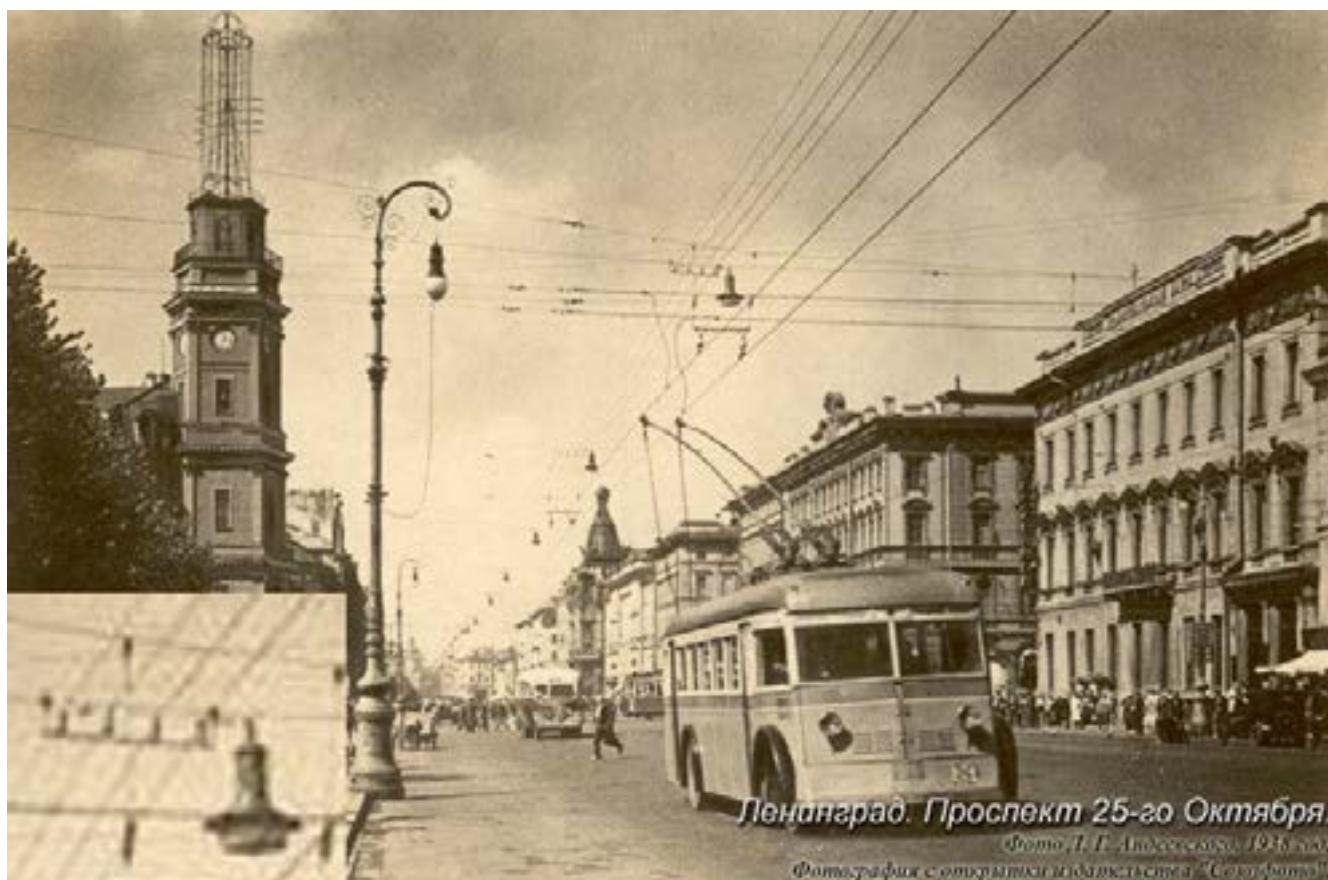
Рис. 18. Четырехпроводная линия освещения. Проспект 25-го Октября (Невский проспект). 1938 год.
