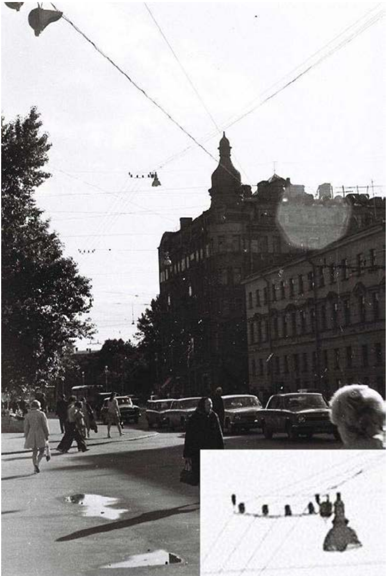
Рис. 67. Линия с СПО-1000, лампой ДРЛ 400 и электромагнитным балластом в оболочке. Загородный проспект.
