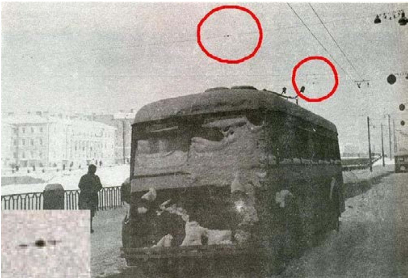
Рис. 10. Такелажные изоляторы на поперечных растяжках освещения и контактной сети. Набережная реки Фонтанки. 1942 год.
