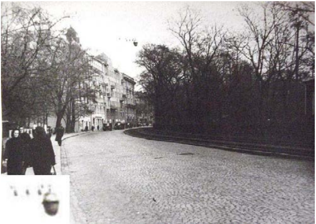
Рис. 44. Светильник СПЗ «НСП-типа». Кронверкский проспект ~1961-1963 год.
