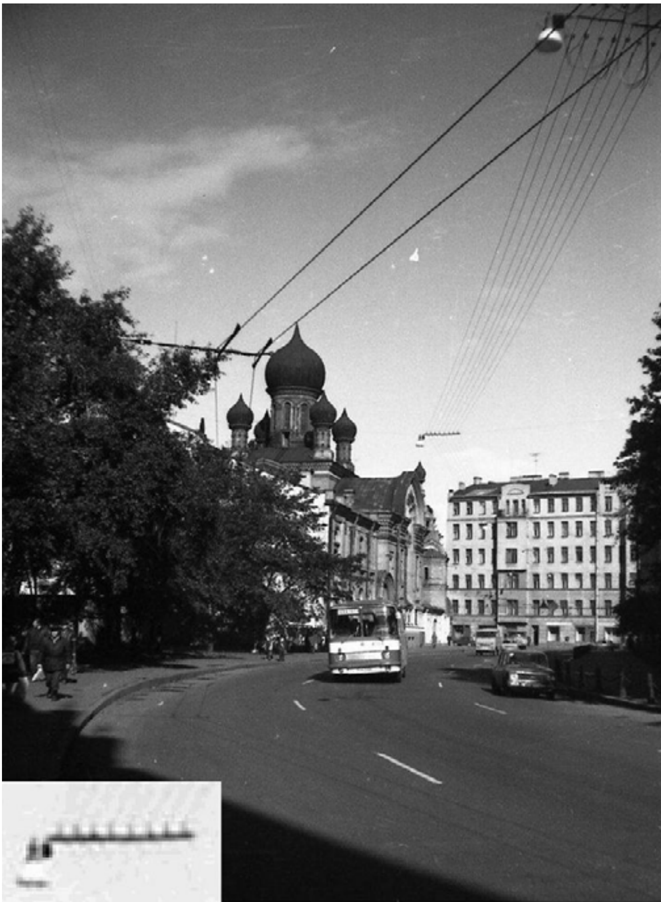
Рис. 107. Восьмипроводная линия. Подсоединение питающих кабелей. Нарвский проспект 1987 год.
