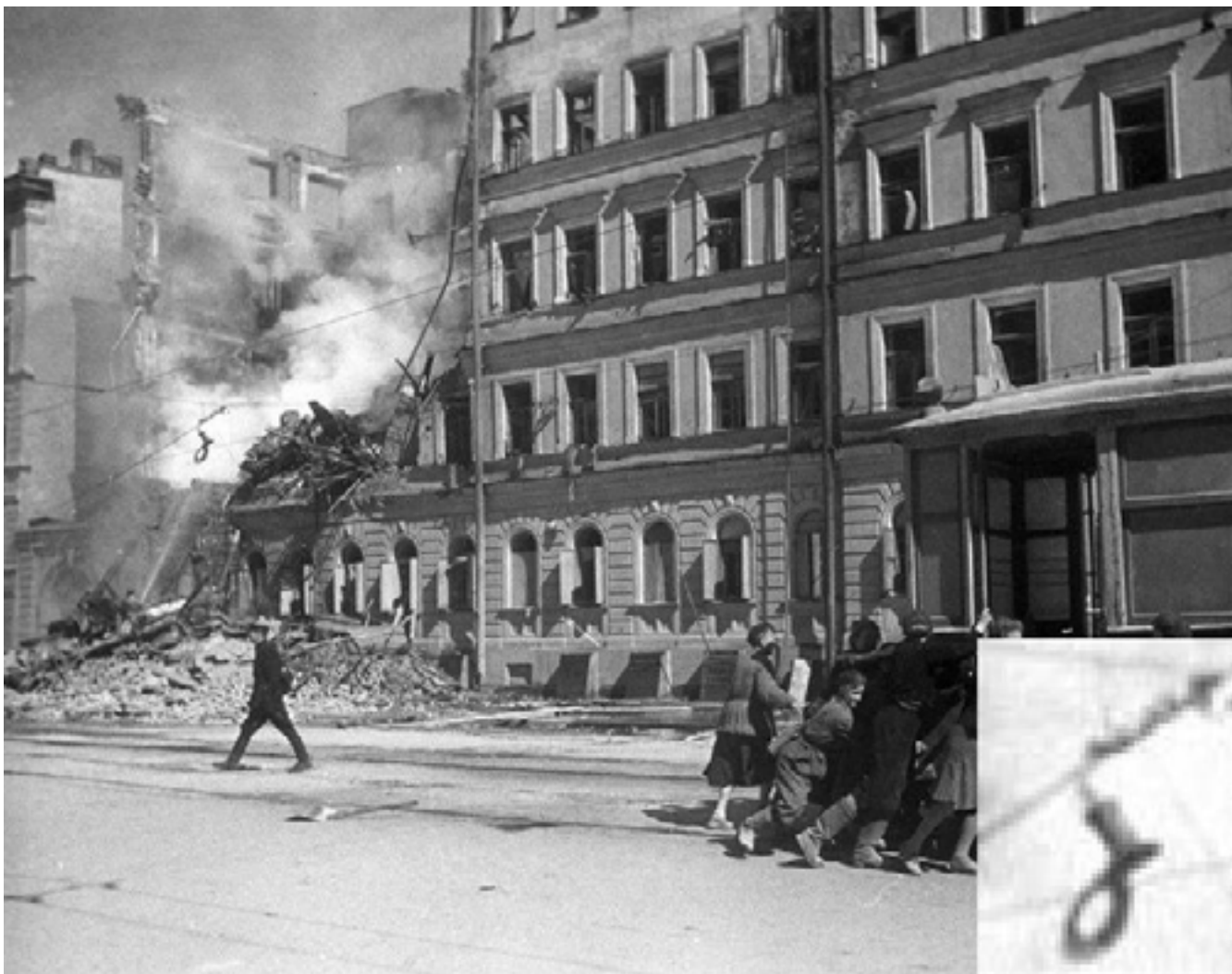
Рис. 19. Поврежденная растяжка централизованного уличного освещения. Проспект 25-го Октября (Невский проспект). 1943 год.
