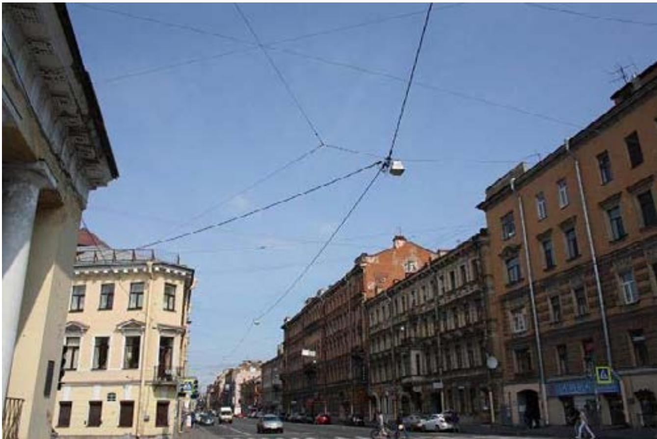
Рис. 135. Линия с СИП с ответвлением, и светильниками ЖСУ17-250-001. Улица Марата. 8 августа 2015 года.
