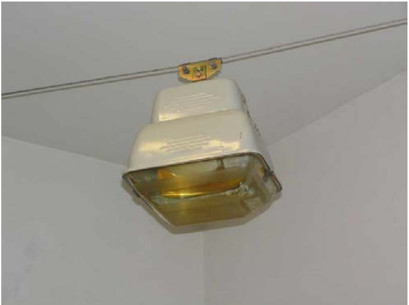
Рис. 129. Светильник РСУ17-250-001-У1. (05.1999) с укороченной крепежной пластиной. Частная коллекция светотехники Сергея Колесникова.
