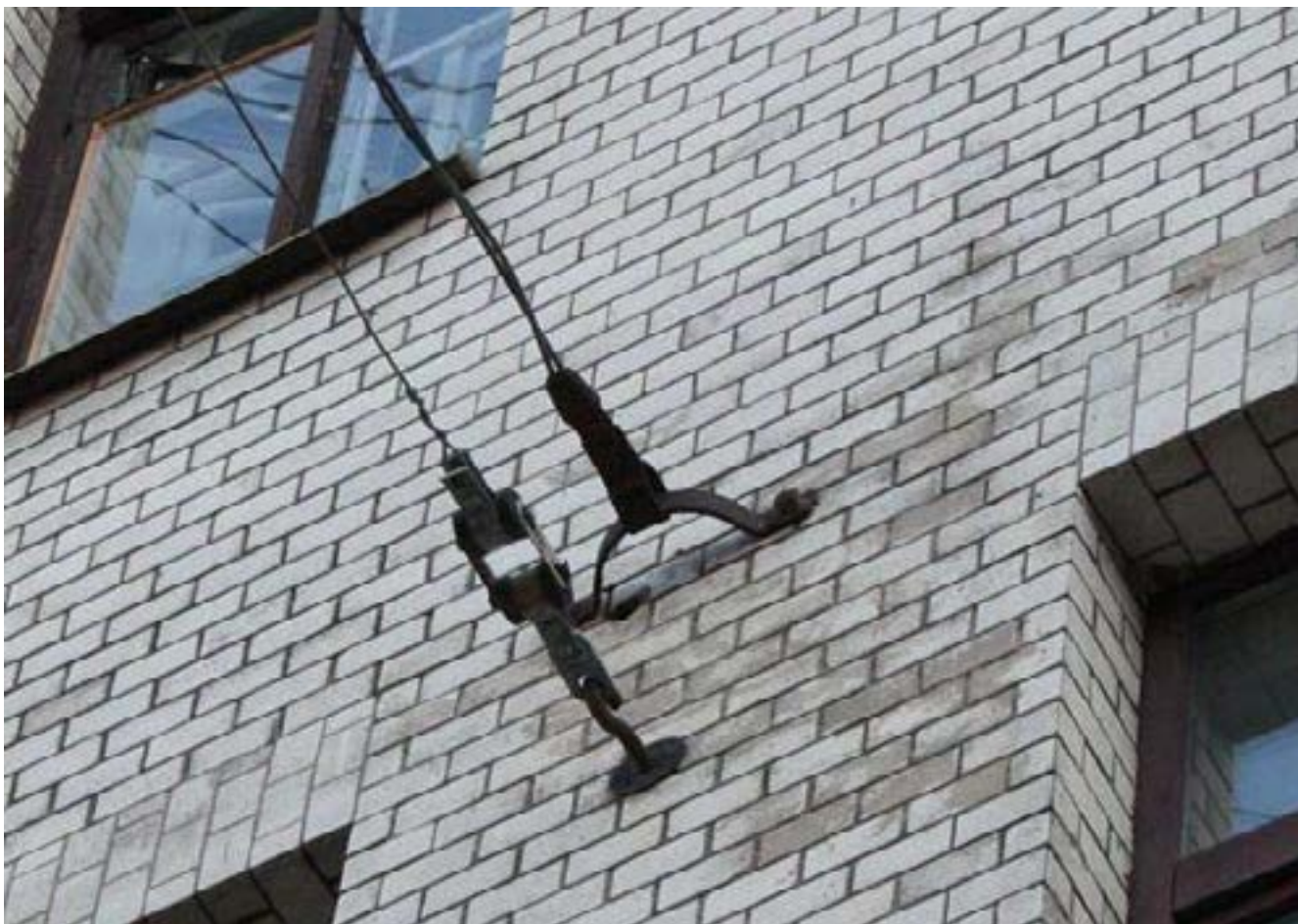
Рис. 158. Узел крепления растяжки к дому. Шумоглушитель нового поколения. Московский проспект. 20 сентября 2015 года.
