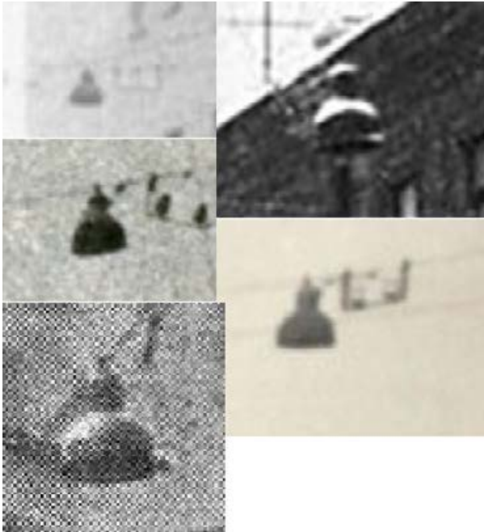
Рис. 22. Светильник с закрытым плафоном для малых улиц и дополнительной подсветки (нарезка и обработка фрагментов из разных снимков).
