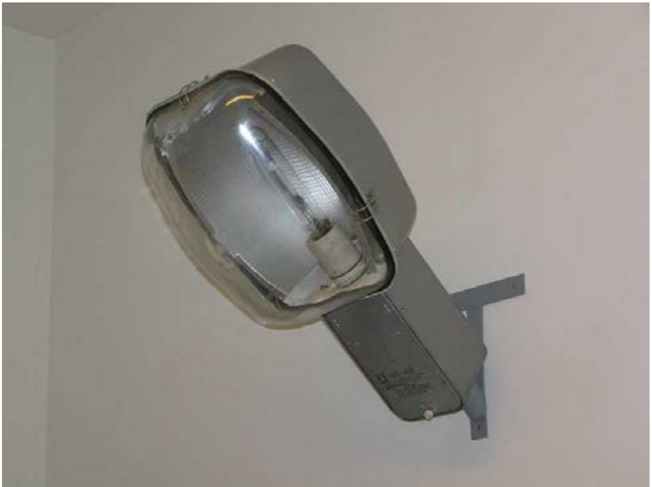
Рис. 115. Светильник ОУС-400 крупным планом. Частная коллекция светотехники Сергея Колесникова.
