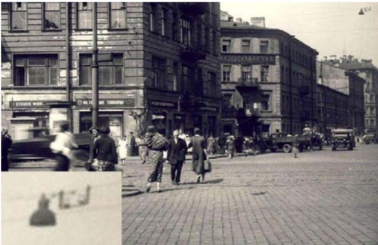
Рис. 5. Типичная двухпроводная сеть подвешного освещения. Лиговский проспект. 1939 год.
