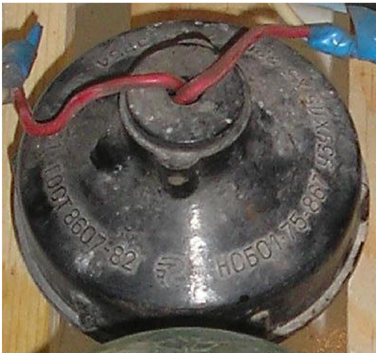
Рис. 30. Светильник НСБ01-75-867 неопознанного завода. Полный аналог НСП03М/НСП29. Фото: 11.05.2006 г.
