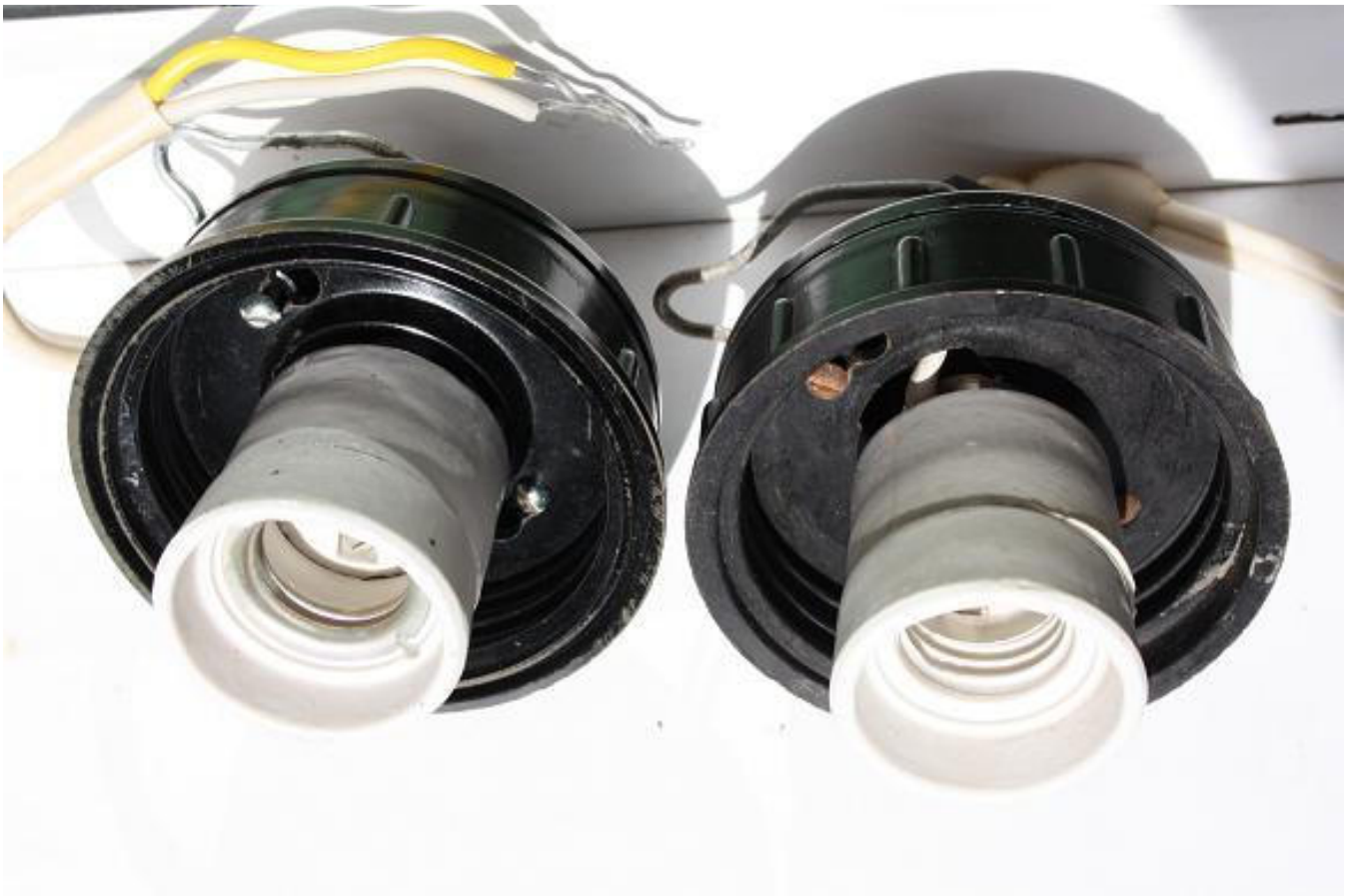
Рис. 24. Сравнение корпусов светильников НСП03: 1987 года (слева) и 1984 года (справа).
