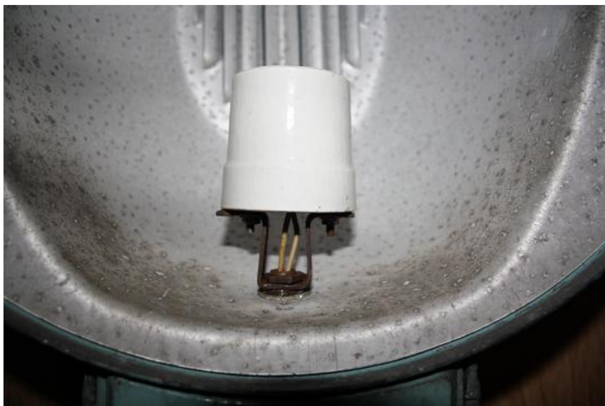
Рис. 31. Патрон ДКС-01. Поздний вариант конусообразной формы закреплен на скобе раннего варианта.
