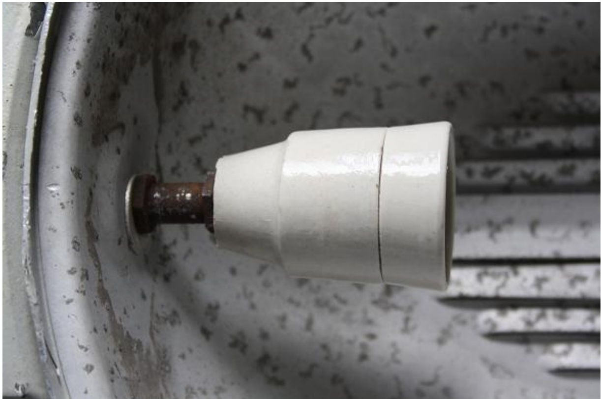
Рис. 4. Узел крепления патрона светильника РКУ07-125-002 (Версия 1) крупным планом.
