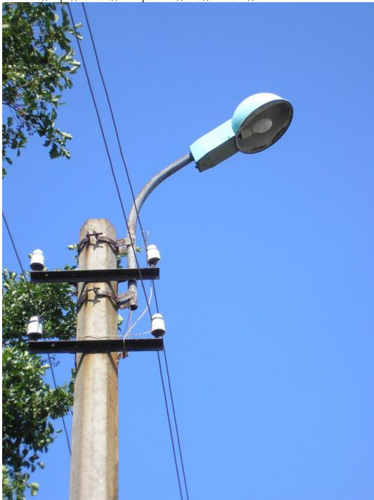
Рис. 27. Светильник РКУ07-125-002 (Версия 2) 1988 год «Бирюзовый с серой крышкой» и цилиндрическим патроном ДКС-01. Поселок Александровская, улица Коробицына. Фотография от 1 августа 2006 года.
