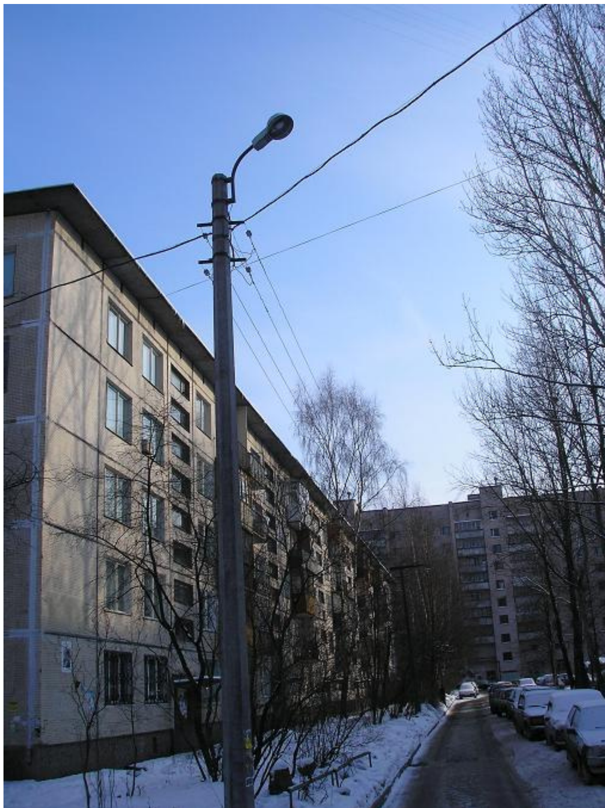
Рис. 59. Светильник РКУ07-125-002 (версия 1) на столбе СВ 1,2-10, поставлен взамен старого со «стрелой». Улица Димитрова. Фотография 8 марта 2006 года.
