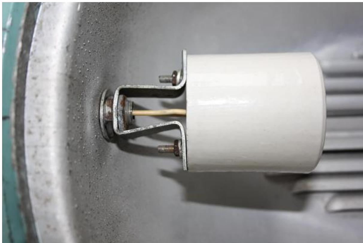
Рис. 18. Фрагмент ЖКУ07-100-002 (версия 2 (1988 год)): Цилиндрический патрон ДКС-01 на стальной крепежной скобе первого варианта.
